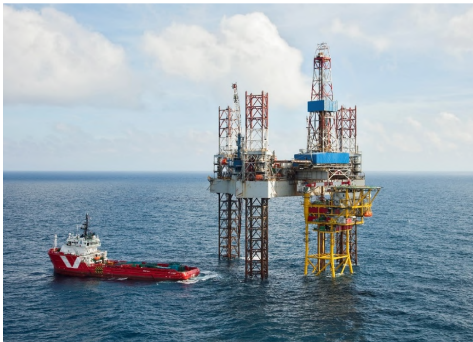
Figuur 5.5: Tijdelijke boorinstallatie ter plaatse van satellietplatform B13-A
