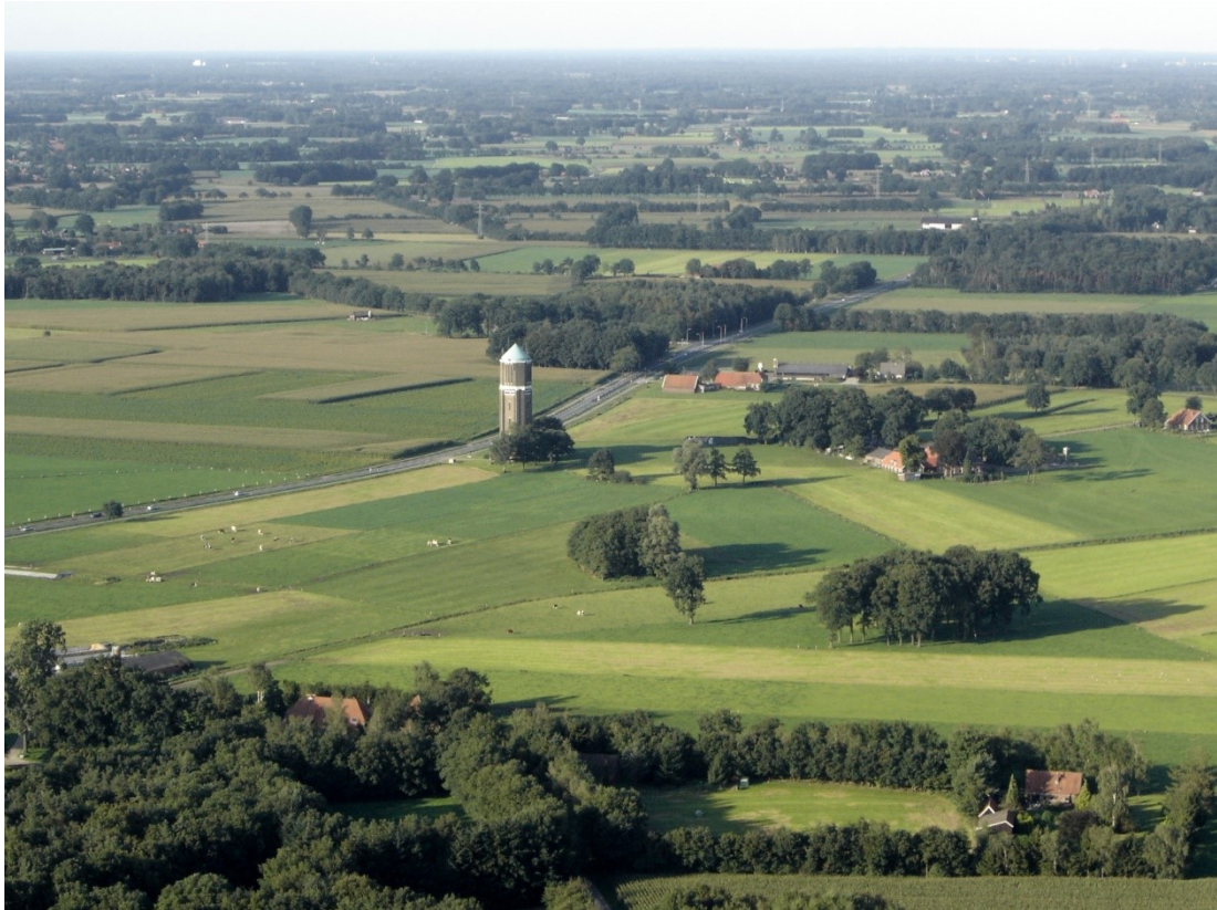
Figuur 2.1 De watertoren in Eibergen aan de Oostzijde van de Haaksbergseweg
