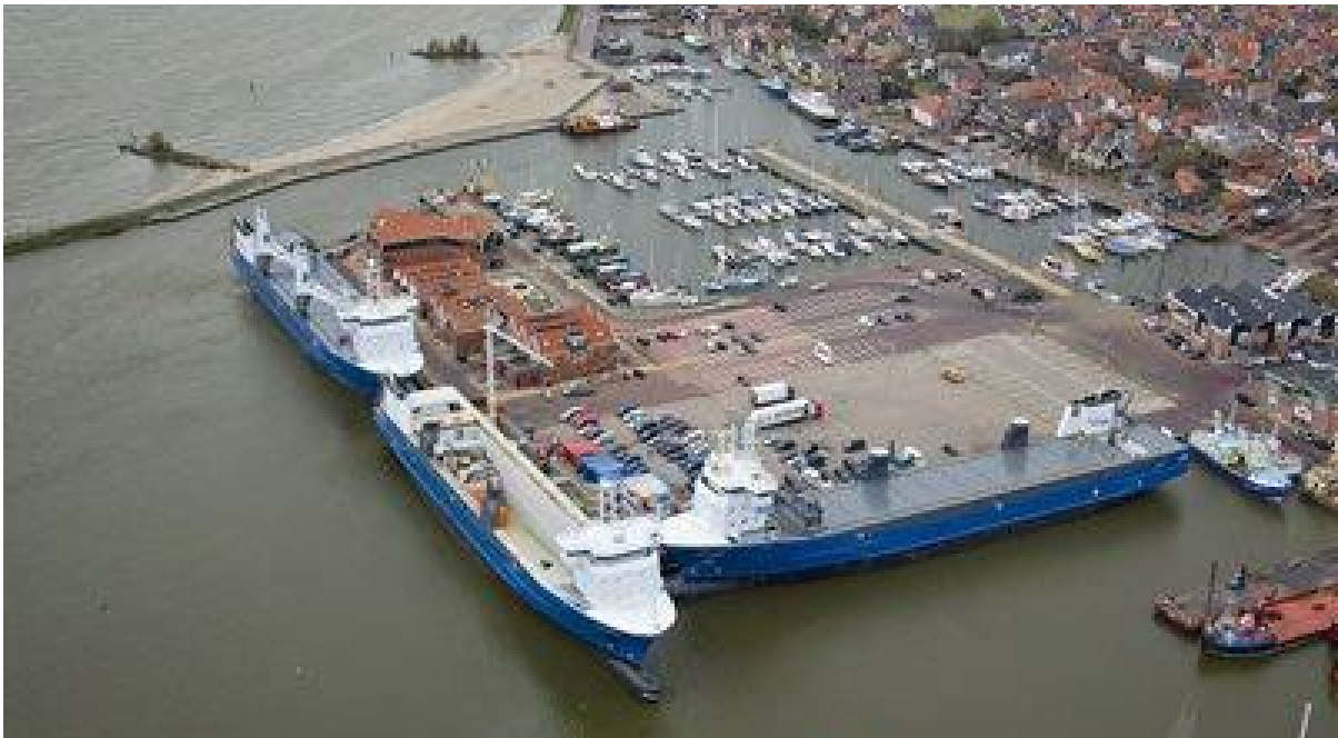
Foto: Bestaande haven Urk
