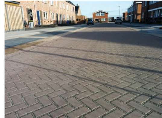
Waterpasserende verharding betonstraatstenen
