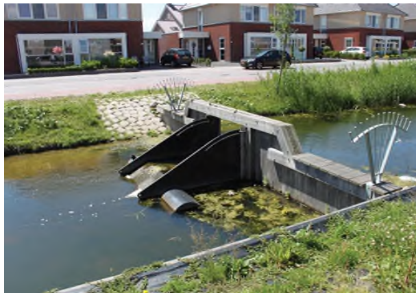
Multiplate duiker in dam afwerken met betonnen oeverbescherming
