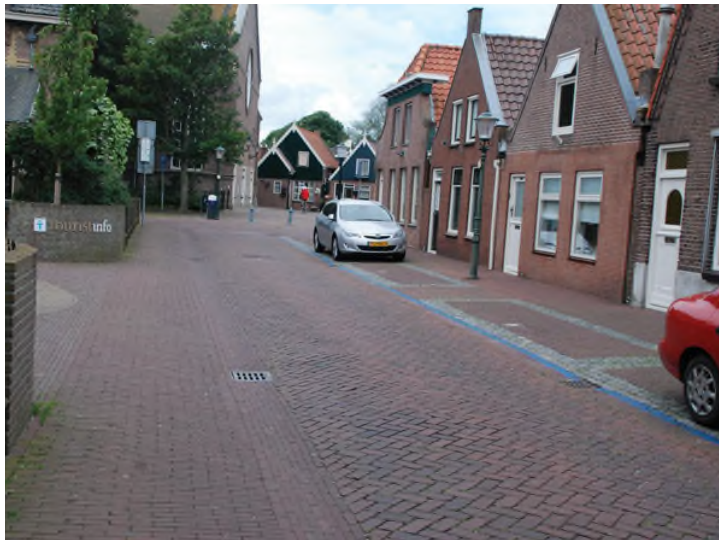
Algemeen straatbeeld Oude Dorp met hoogteverschil trottoir Rijbaan, trottoirs, plateau, parkeren, openbare verlichting, afzetpalen.
