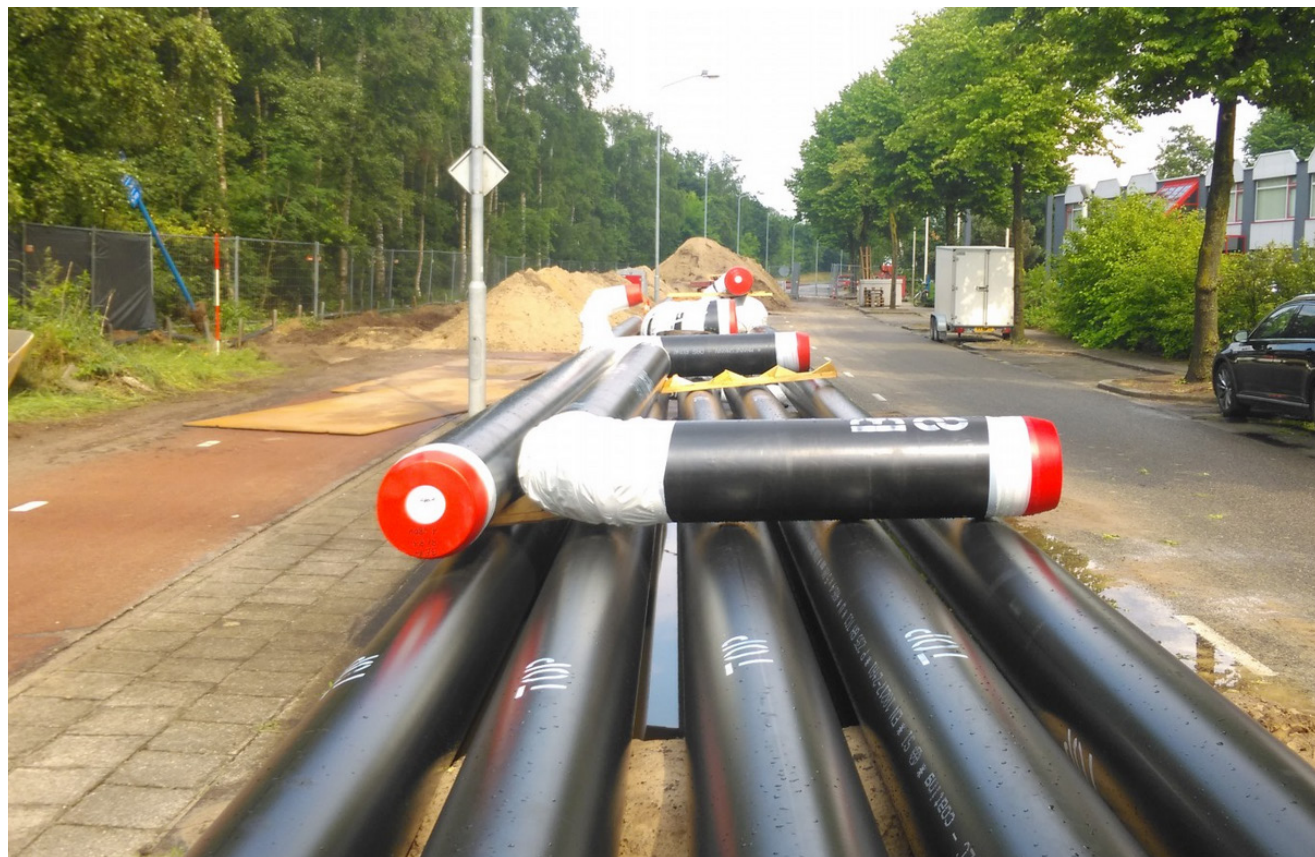
Aanleg van warmtenet (foto: Warmtebedrijf Ede)
