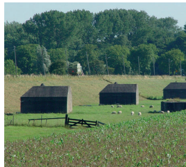
Kazematten bij de Diefdijk
