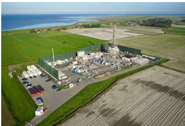
Figuur 6: Luchtfoto van de gaswinlocatie Moddergat tijdens een boring.
