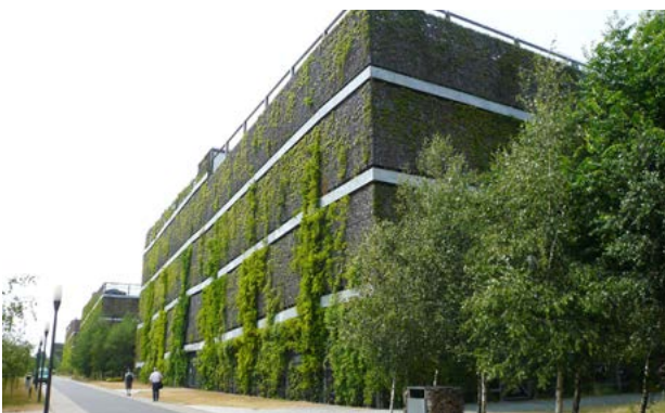
Voorbeeld parkeergarage High Tech Campus Eindhoven
