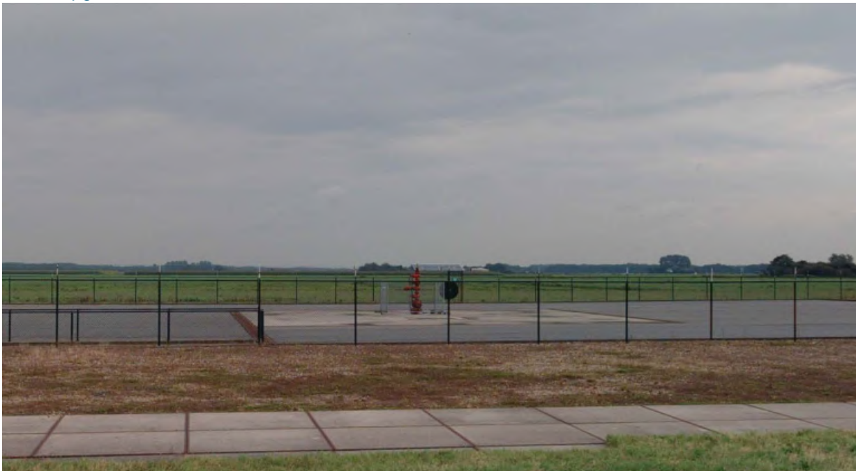
Figuur 2-1 Situatie Nieuwehorne met daarop zichtbaar een afsluiter (foto september 2015)
