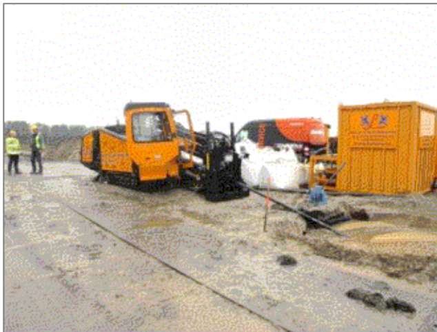
Figuur 5: Booropstelling ten behoeve van een gestuurde boring.
