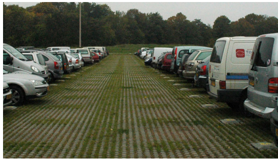
grasbetontegels parkeervakken en rijbaan
