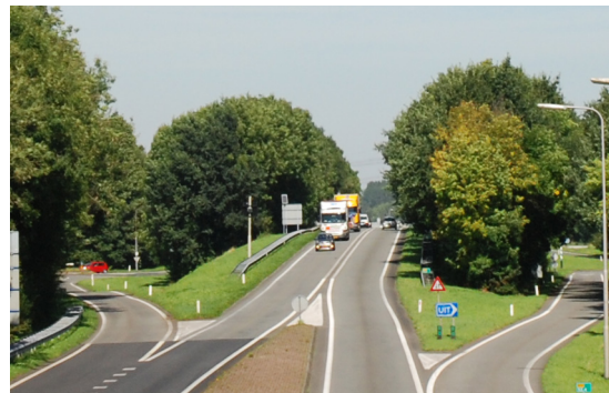
talud beplant, met bomen en heesters
