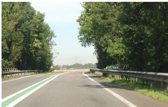
geleiderails aan buitenzijden op talud
