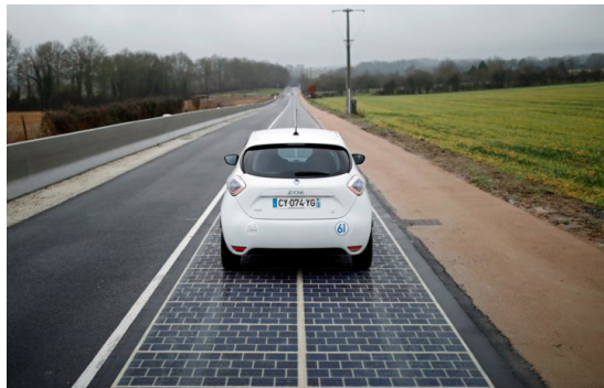
referentie zonnepanelen als proefstrook in de weg
