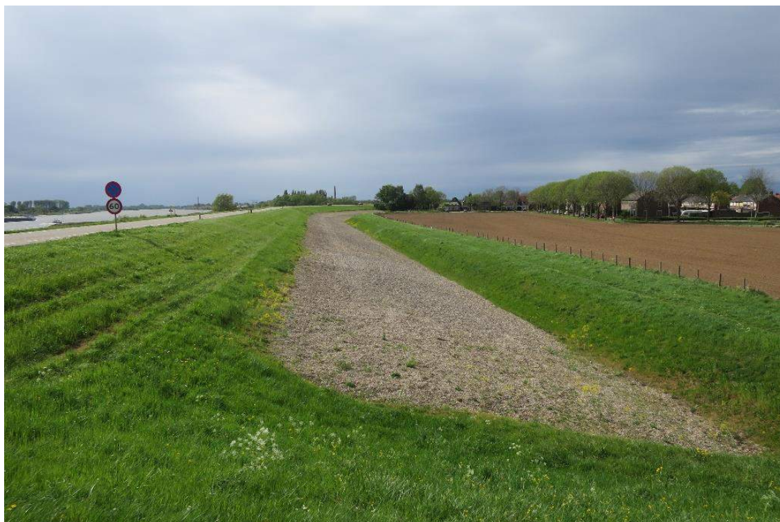
Figuur 2-6 Impact niet afgedekte grindkoffer op continuïteit dijkprofiel (Lievense, 2019)
