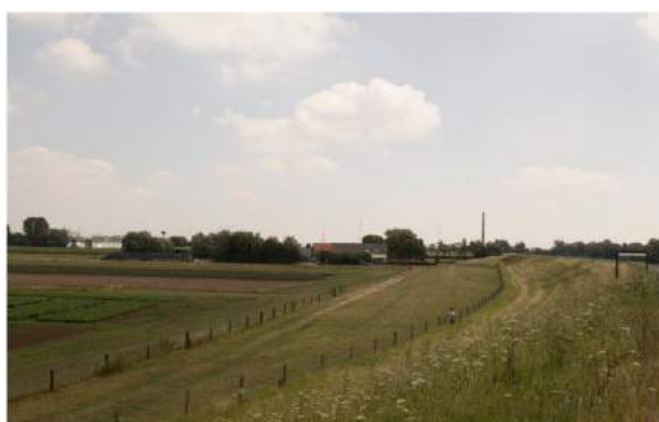
Figuur 5-6 Visualisatie steunberm binnenzijde landelijk gebied (bron: flux)
