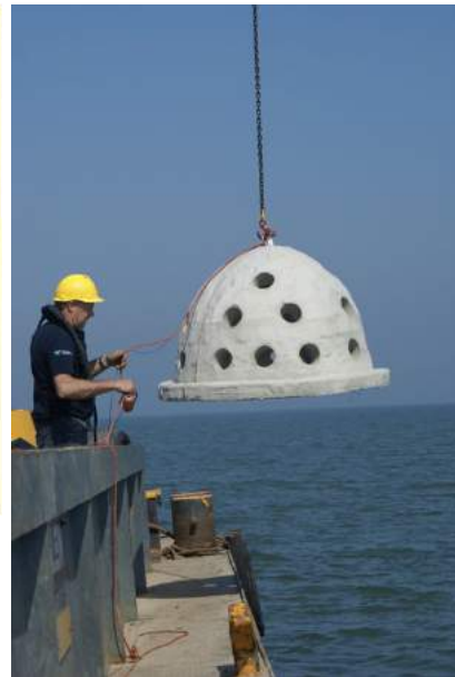
Plaatsen van een rifkorf (rechts) en een rifkorf onderwater begroeid met mosselen (links).
