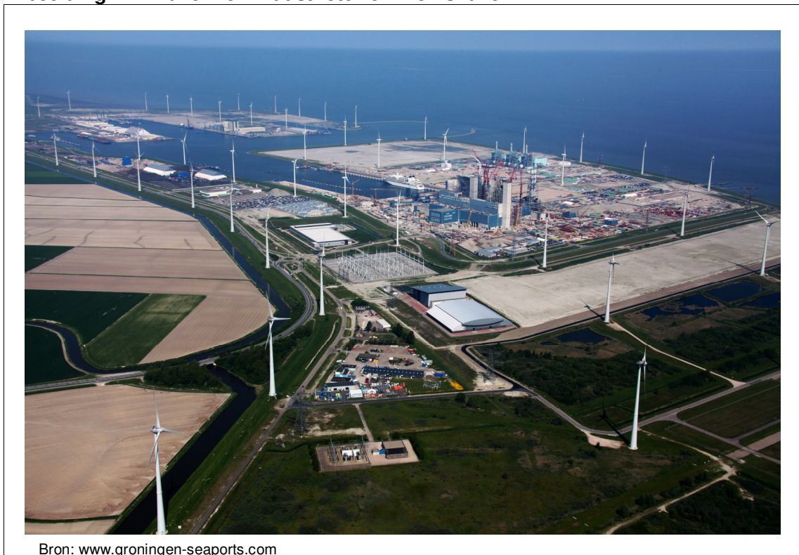
Afbeelding 1.1. Haven- en industrieterrein Eemshaven
