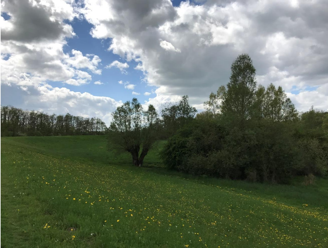
Afbeelding 5.11 Blik op dijkwalud en vegetatie buitendijks op deeltraject 5.3, richting het zuiden
