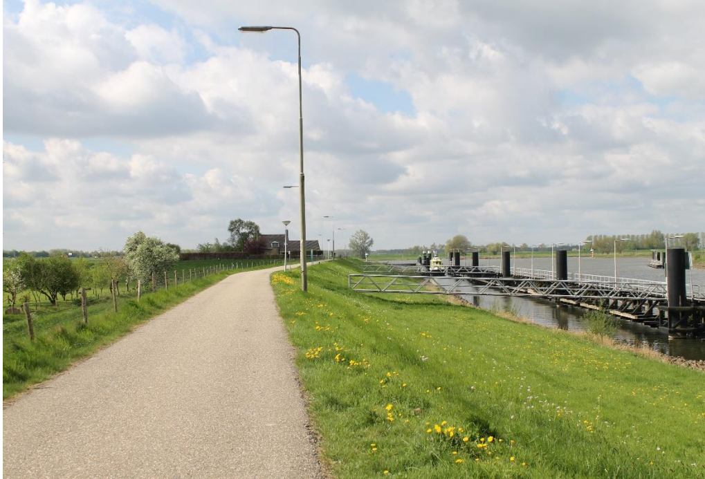
Afbeelding 5.39 Dijk op traject 15.3, ten zuiden van de Spooldersluis
