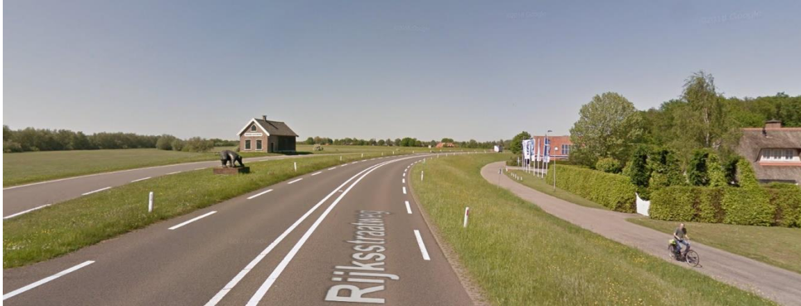
Afbeelding 5.6 Blik op het noordelijke deel van deeltraject 4 richting het noorden, met aan de buitenzijde van de kruin de dijkstoel
