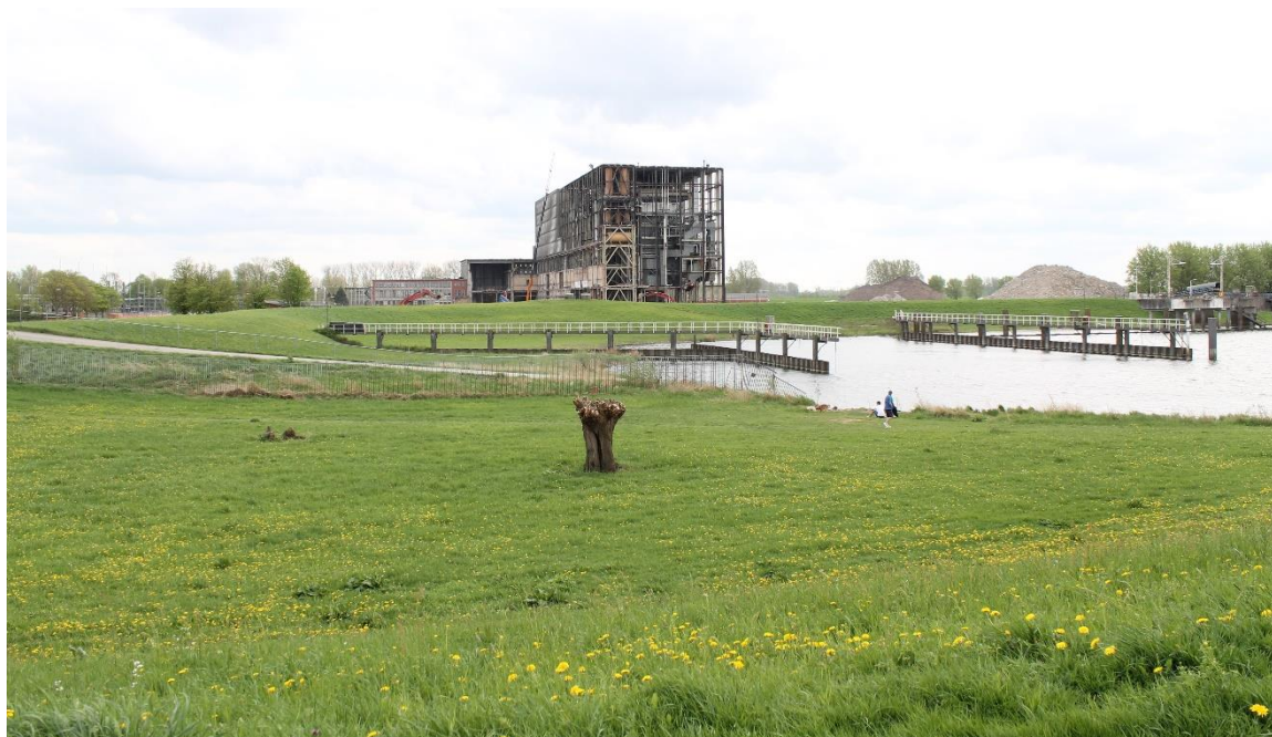
Afbeelding 5.26 Blik op de buitendijkse zijde vanaf de dijk in deeltraject 12.3 met de oude IJsselcentrale en de voormalige haven
