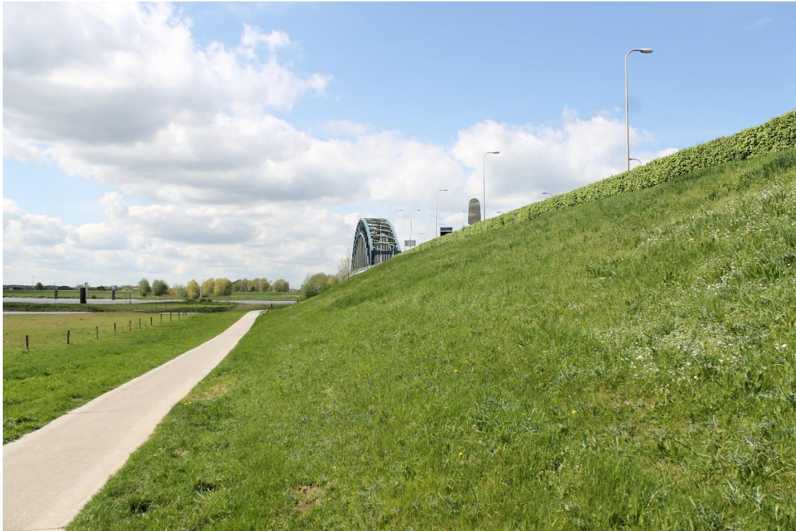
Afbeelding 5.35 Zuidhelling in aanloop naar de IJsselbrug. Het betreft een steil talud veel Rode Lijstsoorten
