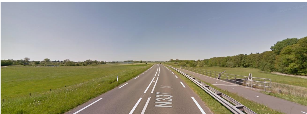
Afbeelding 5.1 Blik op deeltraject 1.1 richting het noorden. Rechts het voormalige inlaatwerk van de IJssellinie in de dijk
