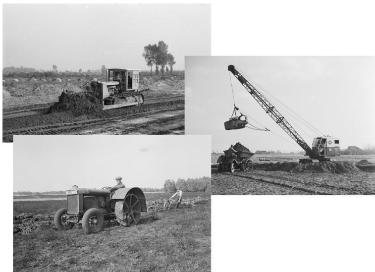
Ontginningswerkzaamheden in de jaren 50. Fotocollectie Nederlandse Heidemaatschappij
