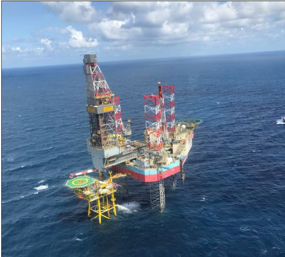
Figuur 3.1: Voorbeeld van een zelfheffend booreiland (rechts) tijdens uitvoering van een boring bij een satellietplatform (links)
