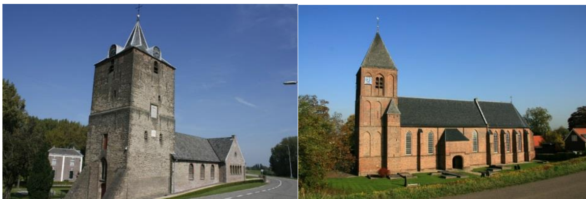
Figuur 2.2: Links de kerk in Dodewaard, daterend uit ca. 1920. De toren is een zwaar aangelegd romaans bouwwerk, opgetrokken uit tufsteen waarschijnlijk omstreeks 1100. Rechts de kerk van IJzendoorn, gebouwd kort na 1348
