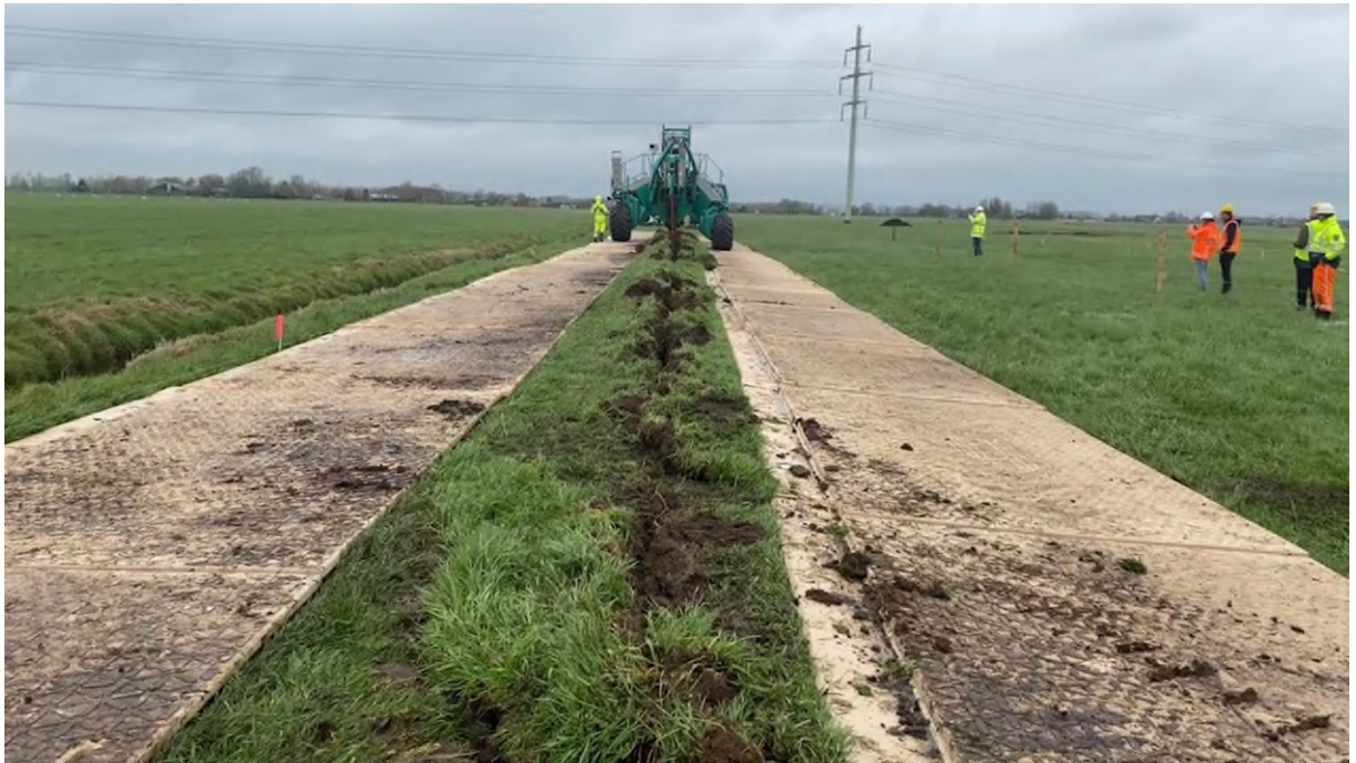
Figuur 2.13: Maaiveld direct na inploegen te Sliedrecht 22 januari 2022 (bron: Gasunie).
