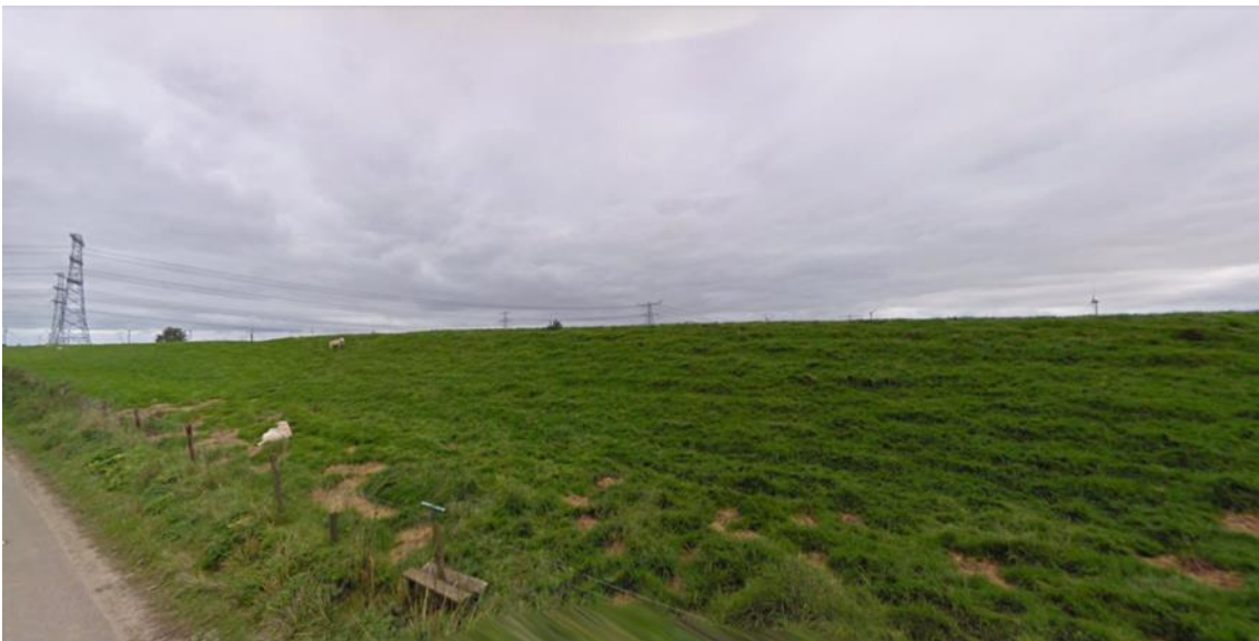
Afbeelding 3.8 De dijk bij Polen: hoogspanningsleidingen domineren het beeld
