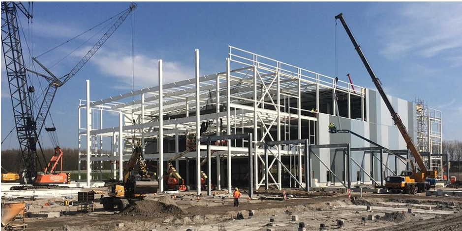
Figuur 3: bouw bedrijfsgebouw
