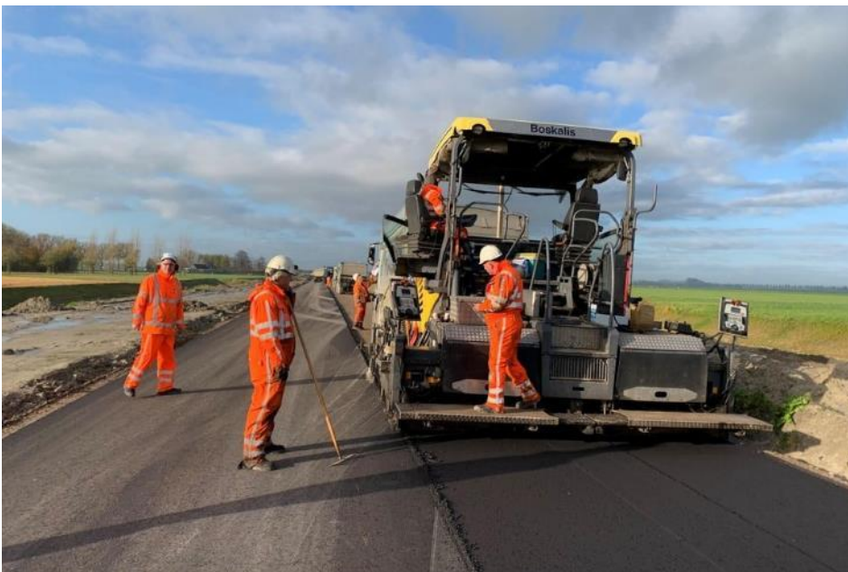
Figuur 1: aanbrengen asfalt met een spreider
