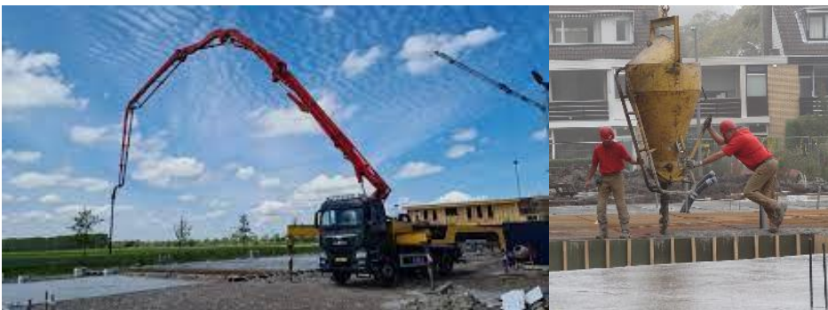
Figuur 2: betonpomp (links) en kubel (rechts)
