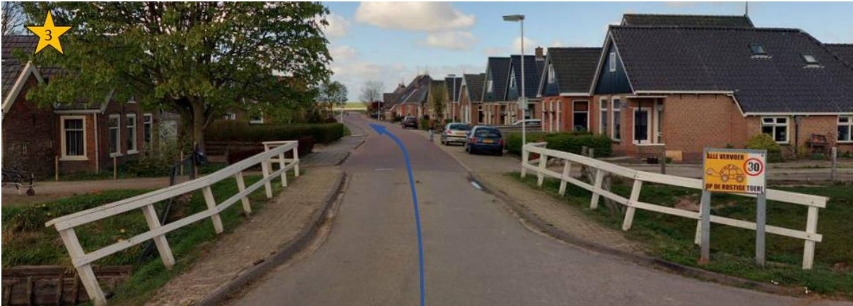
Figuur 19-14 Route 1 doorkruist hier een erftoegangsweg waar een maximumsnelheid geldt van 30 km/uur. Rechts van de weg staat een bord met de tekst "alle vervoer, op de rustige toer". Dit wegprofiel is niet geschikt om vrachtverkeer doorheen te leiden.
