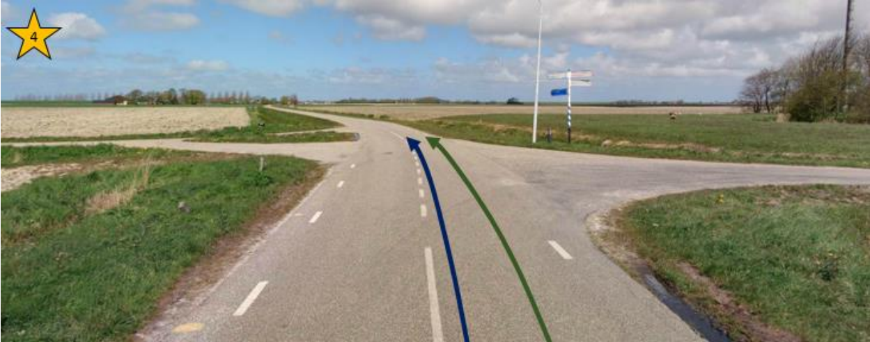
Figuur 19-20 Route 1 en 2 kruisen hier de Nesserwei. De Nesserwei betreft een smalle landweg die tevens de functie vervult van vrij liggend fietspad voor de N358. Hierdoor kunnen er conflicten ontstaan tussen fietsers en vrachtverkeer.
