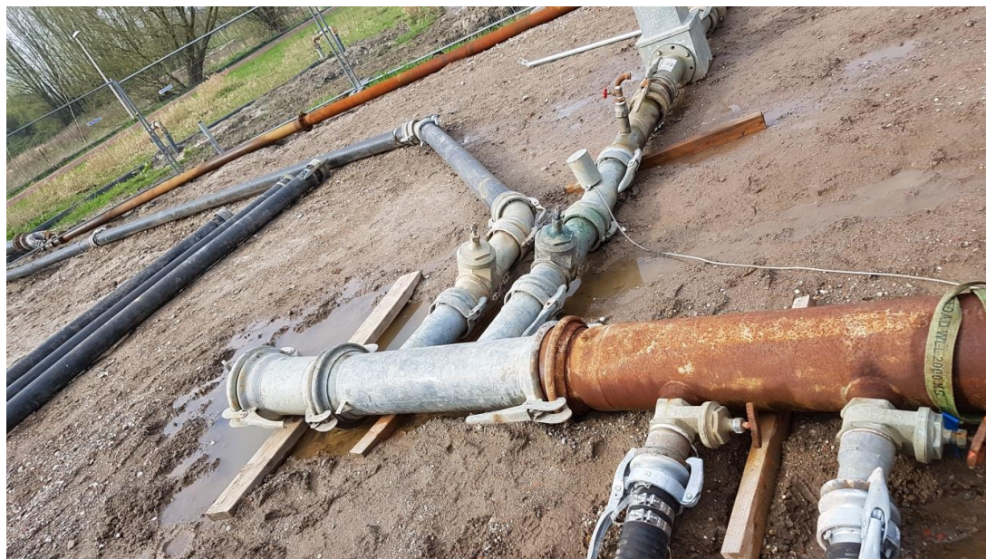
Figuur 12.4 Verdeelstuk naar DSI-systeem 1 achter zuivering en leiding naar retourveld 2
