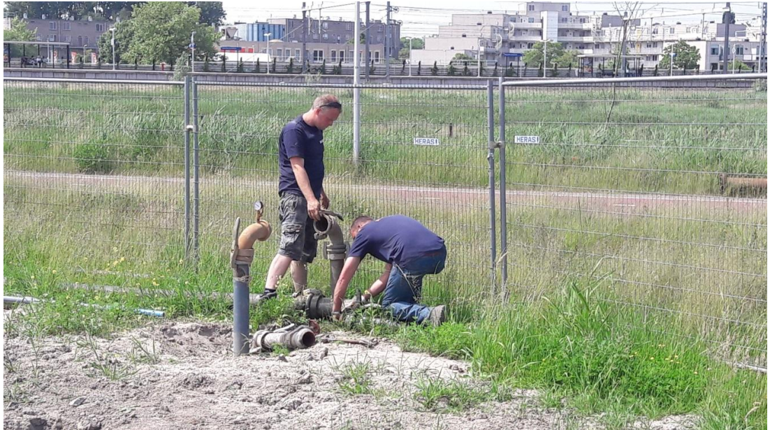
Figuur 12.11 Plaatsing DSI-streng 1 nabij zuivering
