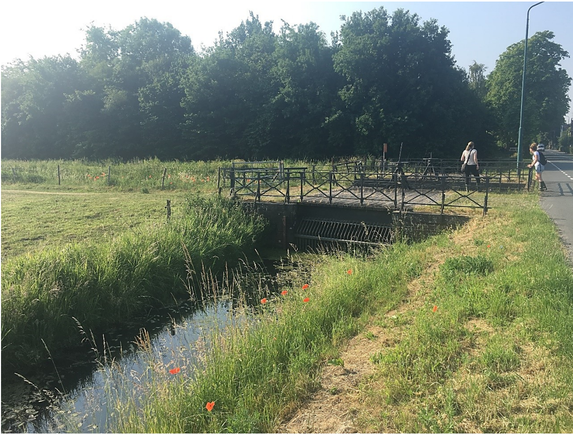
Figuur 35. De Hoge Vaart met het laat 19e eeuwse sluiscomplex op de kruising met het Zuider Afwateringskanaal (Arcadis).
