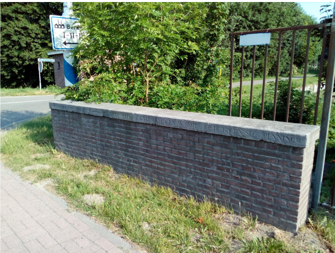
Figuur 44. Gemetselde deel van de duikersluis in de Hoge Vaart Naast de Winterdijk (Arcadis).
