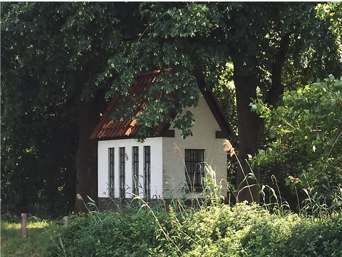
Figuur 42. Gerestaureerd vijzelgemaal uit 1937 in de Dullaert (Arcadis).
