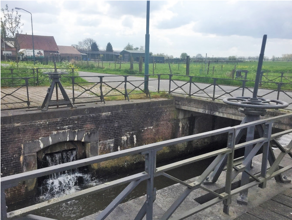
Figuur 45 Sluis in het ZAK (Arcadis).
