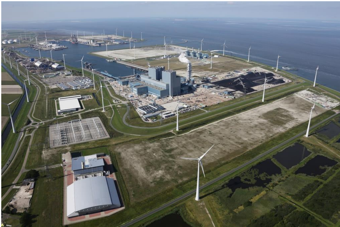
Afbeelding 1.3 Haven- en industrieterrein Eemshaven
