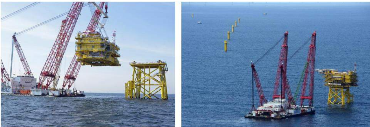
Figuur 6: Impressie van het plaatsen van de topside.
