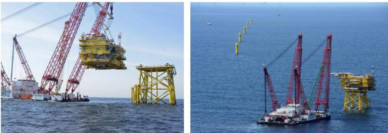
Figuur 7: Impressie van het plaatsen van de topside.
