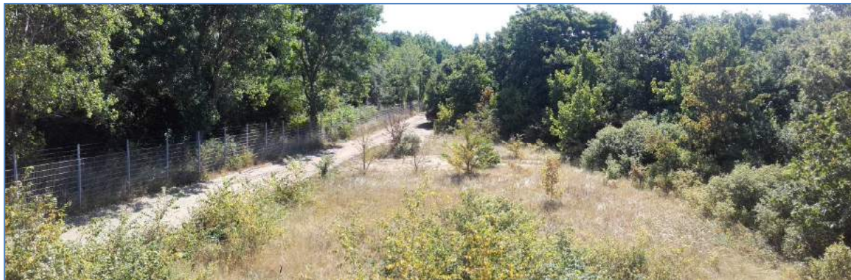
Figuur 11. Impressie van deelgebied 8 Transformatorstation (Tata Steel) ter hoogte van boring 71. Kijkrichting is naar het oosten.
