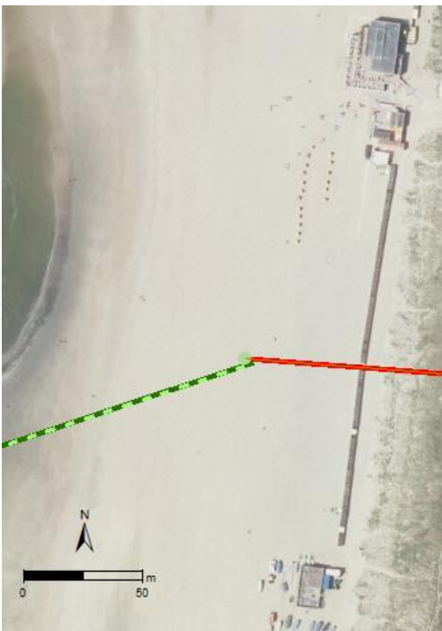
Figuur 10-33 Strandpaviljoens en strandhuisjes nabij de locatie van de mofputten. De mofputten worden gebouwd in de buurt van de locatie waar de lichtgroene stip zich bevindt.
