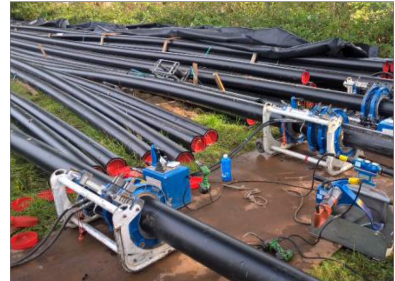
fig. 6 Mantelbuizen op uitleglocaties
