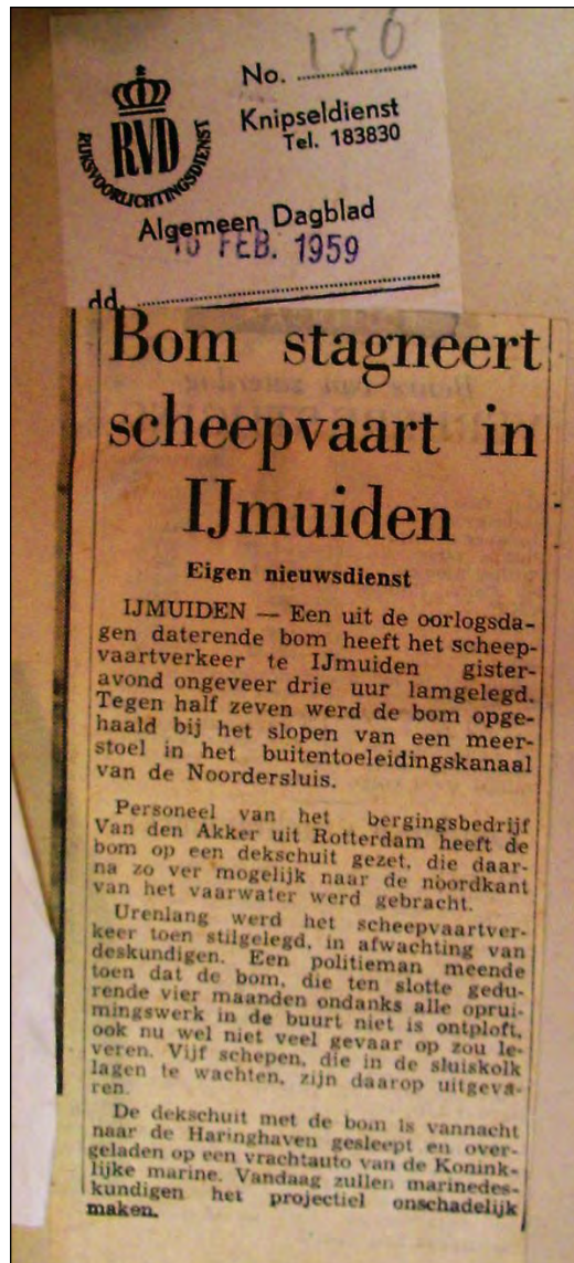
Afb.15 - Vondst dieptebom bij de Noordersluis in 1959.
