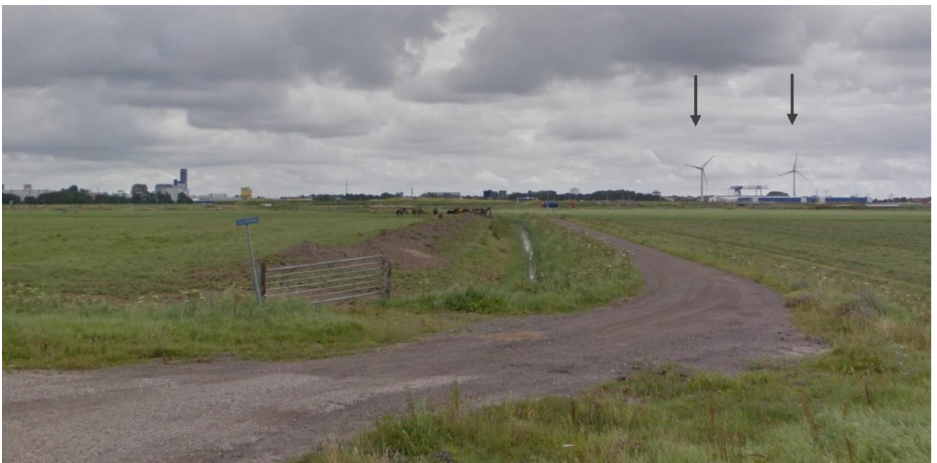
Middelgrote turbines Newtonpark (beeld vanaf noordwesten, Hegedyk)
