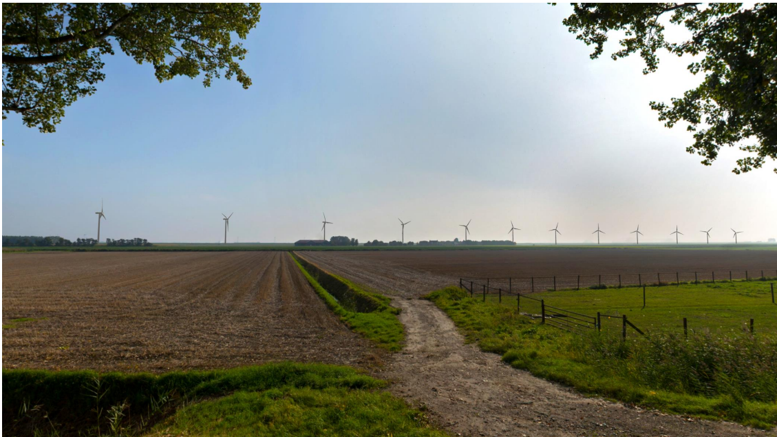
Figuur 3.1: Zicht op plangebied met bestaand windpark vanaf de zuidrand van de kern Ooltgensplaat (uit MER bijlage E Visualisaties, fotopunt FP09)
