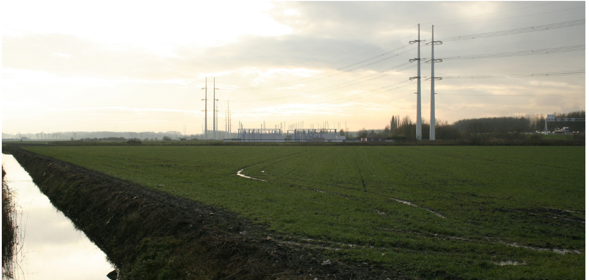
Standpunt 4 Beverwijk Kagerweg - Visualisatie van het effect van het nieuwe transformatorstation Beverwijk Kagerweg.
