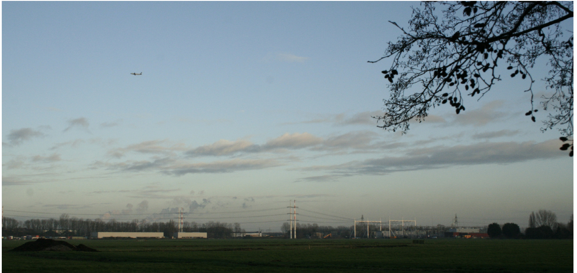
Standpunt 10 Vijfhuizen - Zicht op de locatie van het nieuw te realiseren transformatorstation Vijfhuizen vanuit zuidwestelijke richting, met op de voorgrond de Haarlemmermeerpolder en op de achtergrond het bestaande hoogspanningsstation bij bedrijventerrein De Liede.
