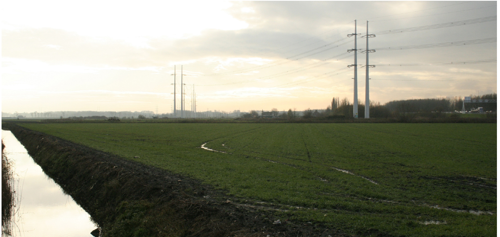
Standpunt 4 Beverwijk Kagerweg - Zicht op de locatie van het nieuw te realiseren transformatorstation Beverwijk Kagerweg, gelegen in de Wijkermeerpolder, vanuit noordoostelijke richting, gelegen.
