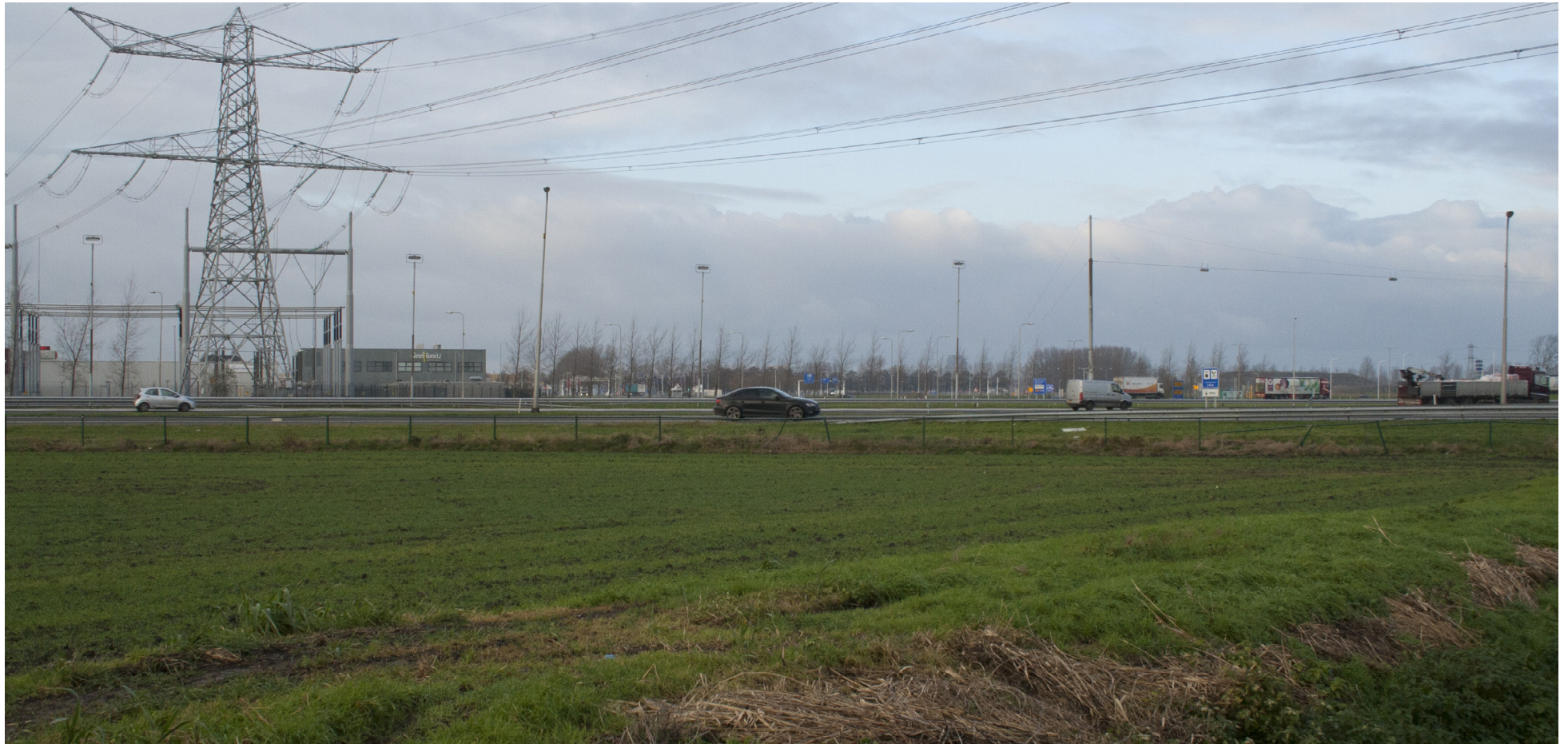
Standpunt 2 Beverwijk Bazaar - Zicht op de locatie van het nieuw te realiseren transformatorstation Beverwijk Bazaar vanuit noordoostelijke richting, op de voorgrond de Rijksweg A9 bij de afslag Beverwijk Bazaar.
