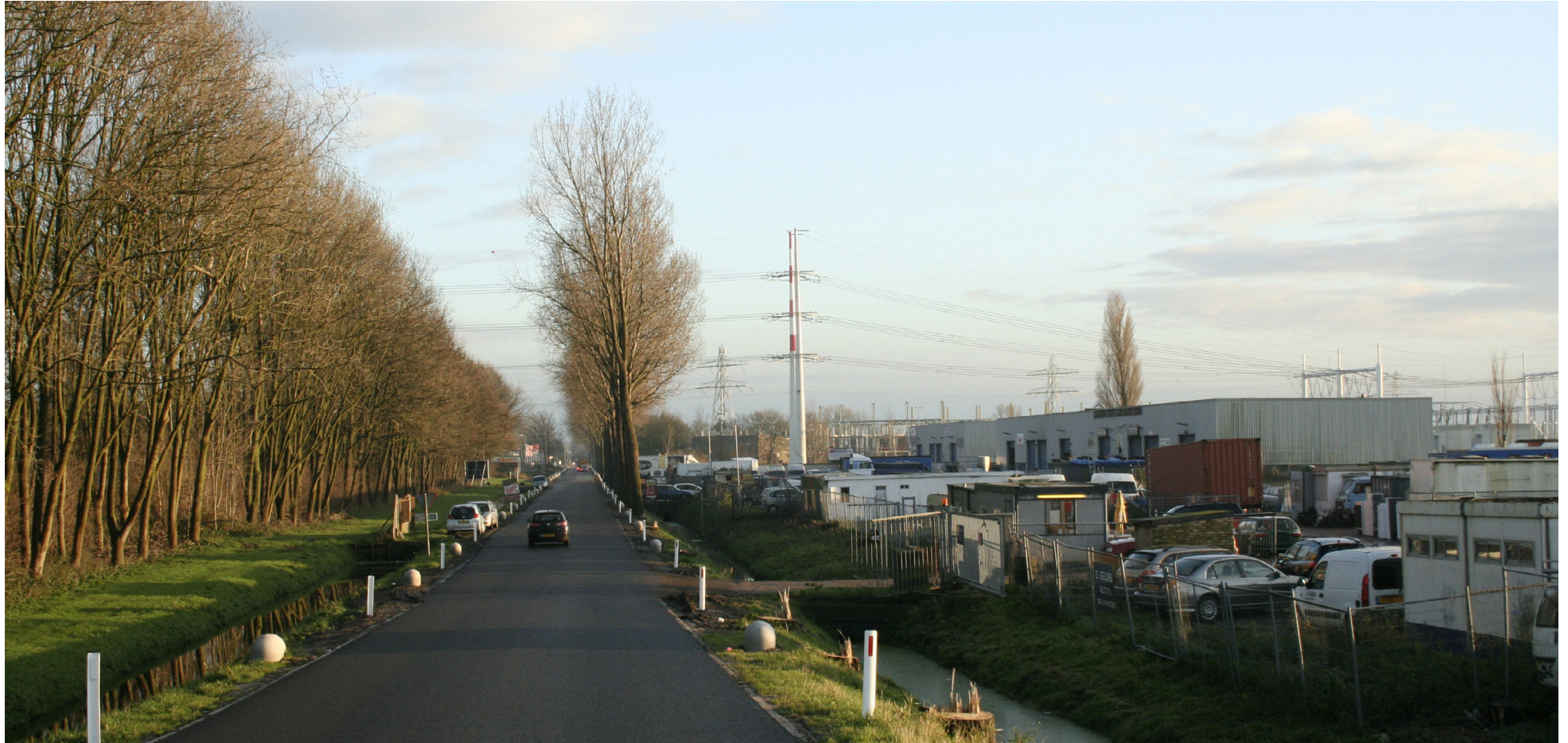
Standpunt 8 Vijfhuizen - Zicht op de locatie van het nieuw te realiseren transformatorstation Vijfhuizen vanuit zuidwestelijke richting, met zicht op bedrijventerrein De Liede en het bestaande hoogspanningsstation.
