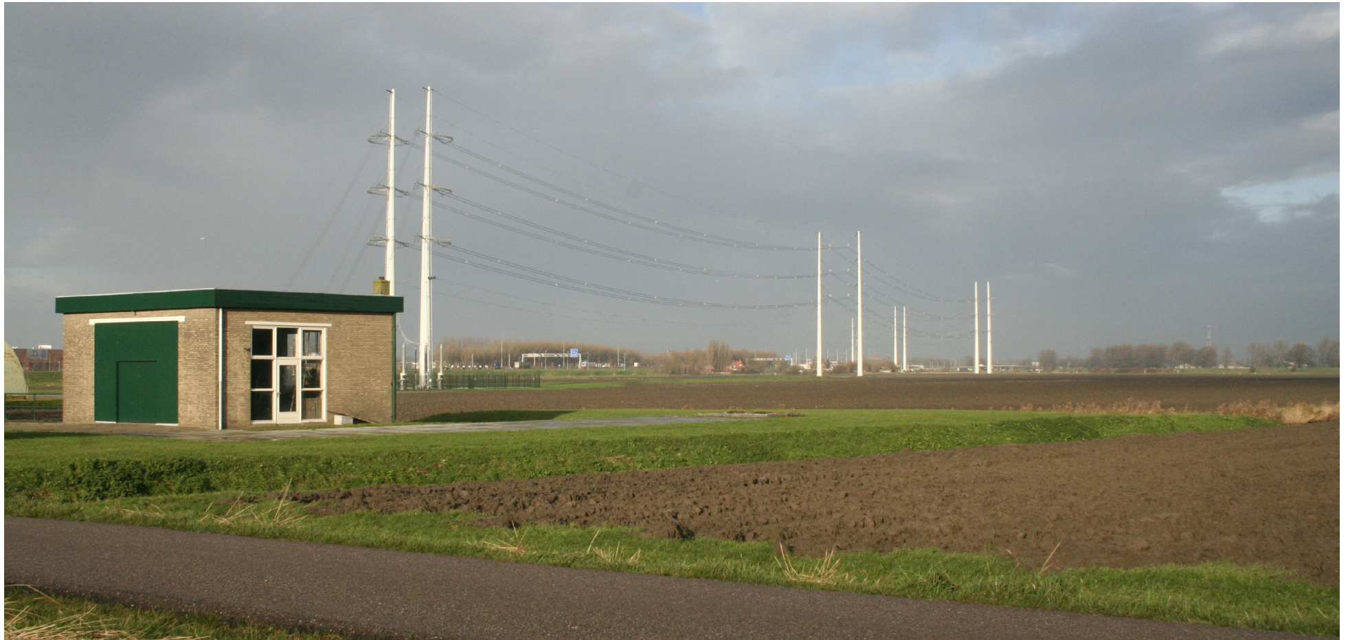
Standpunt 6 Beverwijk Kagerweg - Zicht op de locatie van het nieuw te realiseren transformatorstation Beverwijk Kagerweg vanuit zuidoostelijke richting, met op de voorgrond de Wijkermeerpolder en op de achtergrond de Rijksweg A9.
