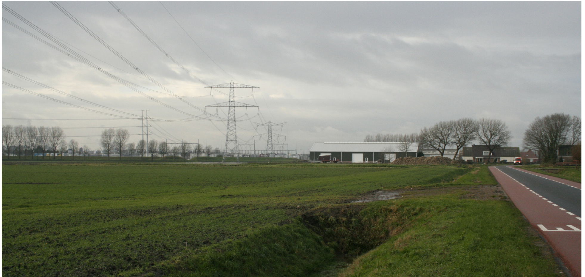
Standpunt 1 Beverwijk Bazaar - Zicht op de locatie van het nieuw te realiseren transformatorstation Beverwijk Bazaar vanuit oostelijke richting, op de voorgrond het bestaande hoogspanningsstation op het bedrijventerrein Kagerweg in Beverwijk.
