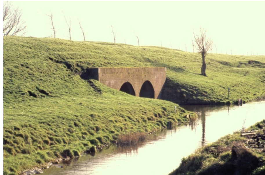
Damsluis in de Liniewal Aagtendijk - Zuidwijkermeer.
