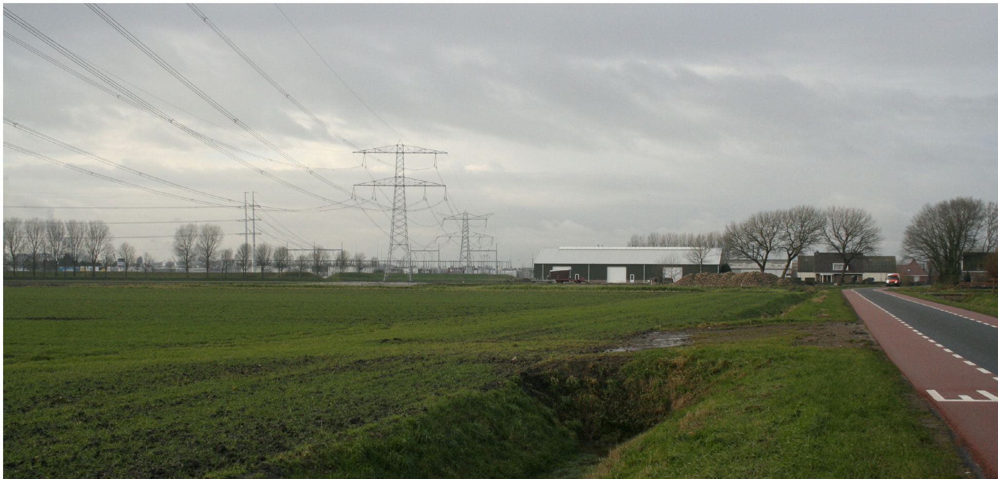
Standpunt 1 Beverwijk Bazaar - Visualisatie van het effect van het nieuwe transformatorstation Beverwijk Bazaar.
