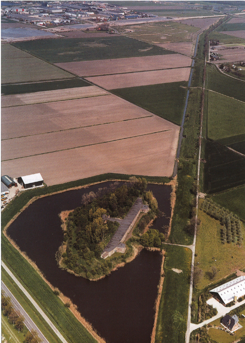
Het Fort Zuidwijkermeer. Vanaf het fort in noorderlijke richting loopt de liniewal Aagtendijk - Zuidwijkermeer die onder andere als inundatiekering diende. In de wal is een aantal damsluizen te herkennen (Vesters, 2003).
