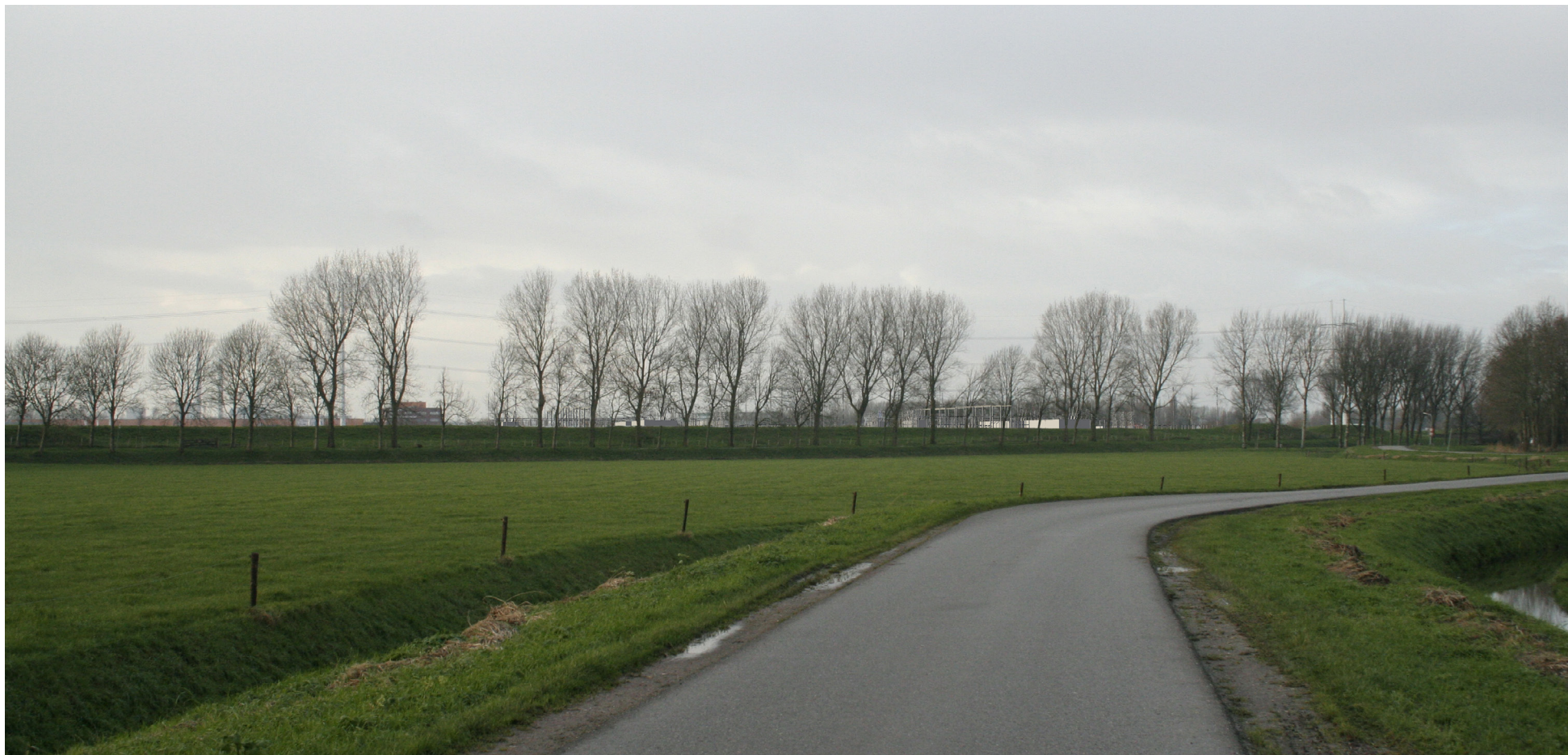
Standpunt 3 Beverwijk Kagerweg - Visualisatie van het effect van het nieuwe transformatorstation Beverwijk Kagerweg.
