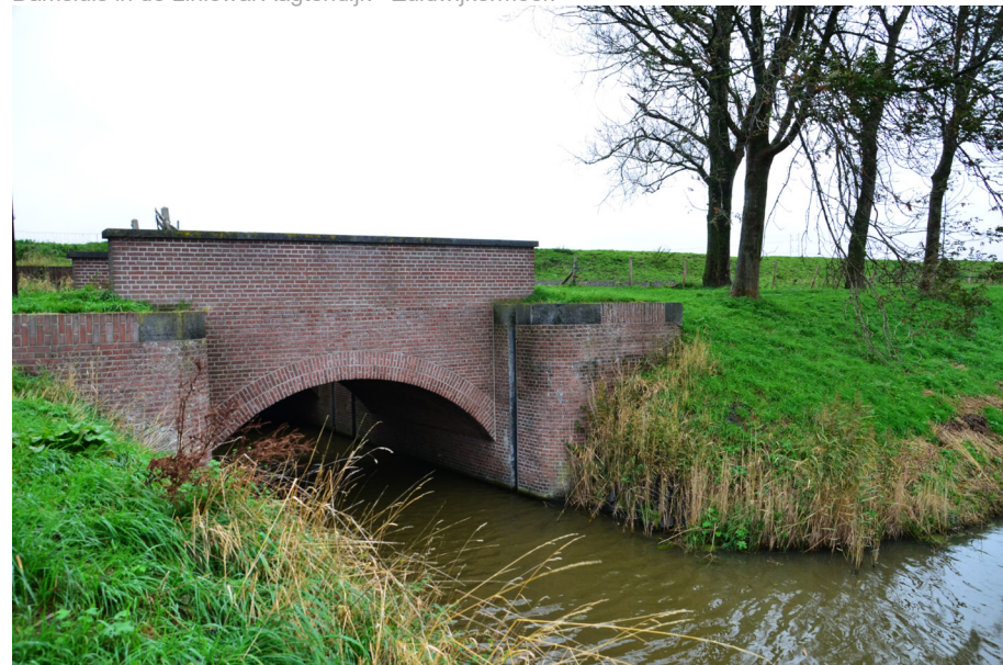
Damsluis in de Liniewal Aagtendijk - Zuidwijkermeer.
