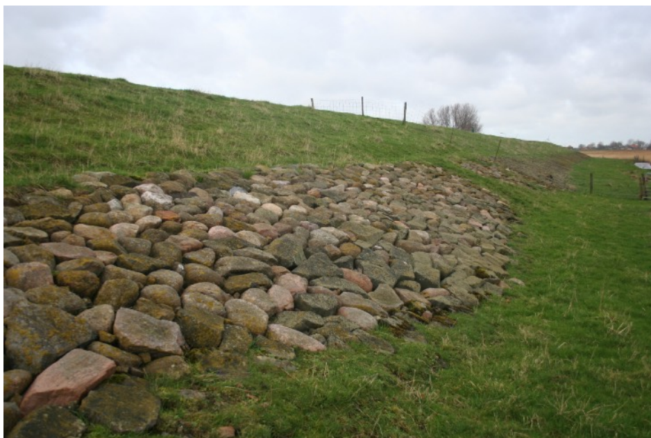
Buitentalud met Noordse steen.
