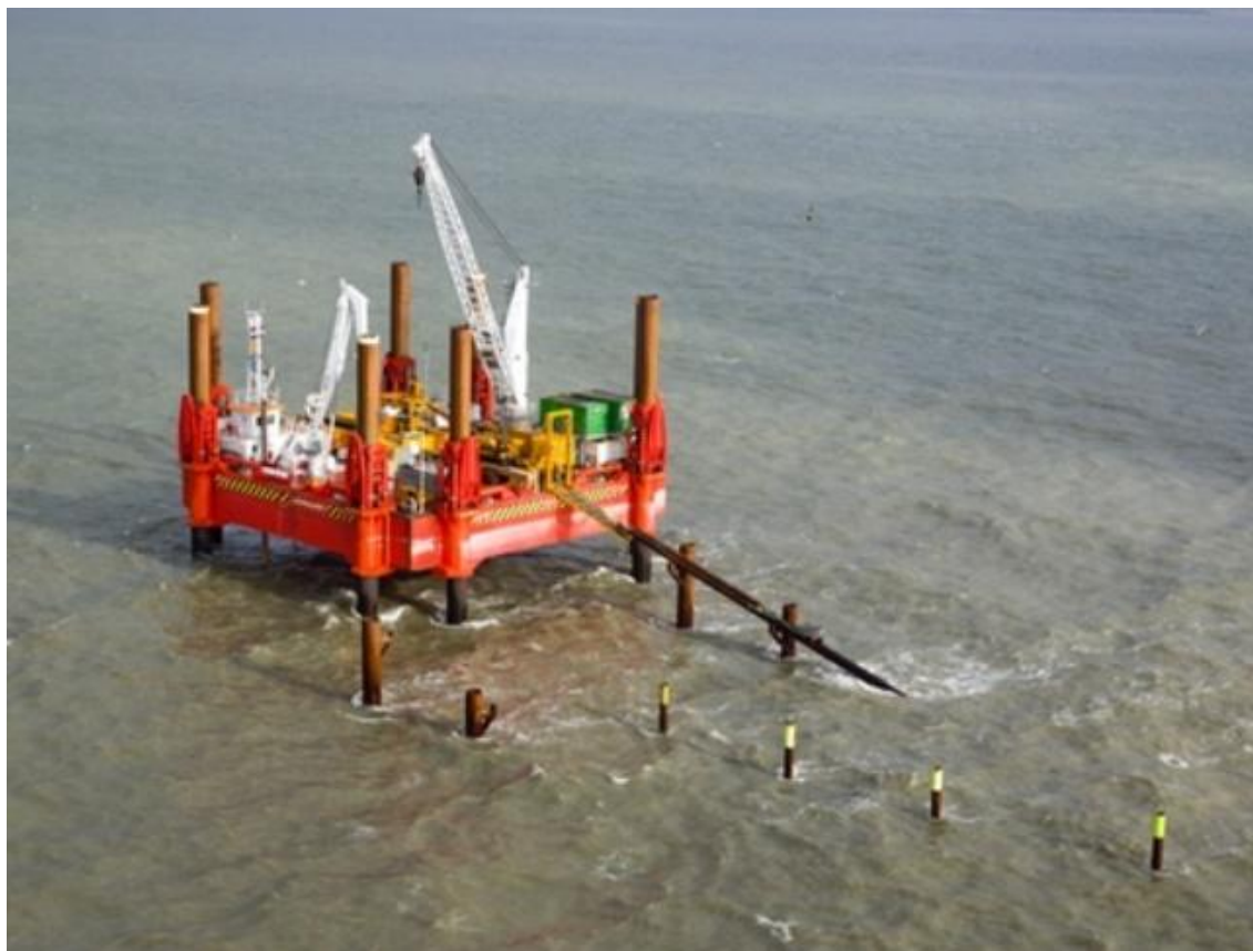
Figuur 4 Het WaveWalker 1 platform op Gemini met casing voor de boring in de stroming
