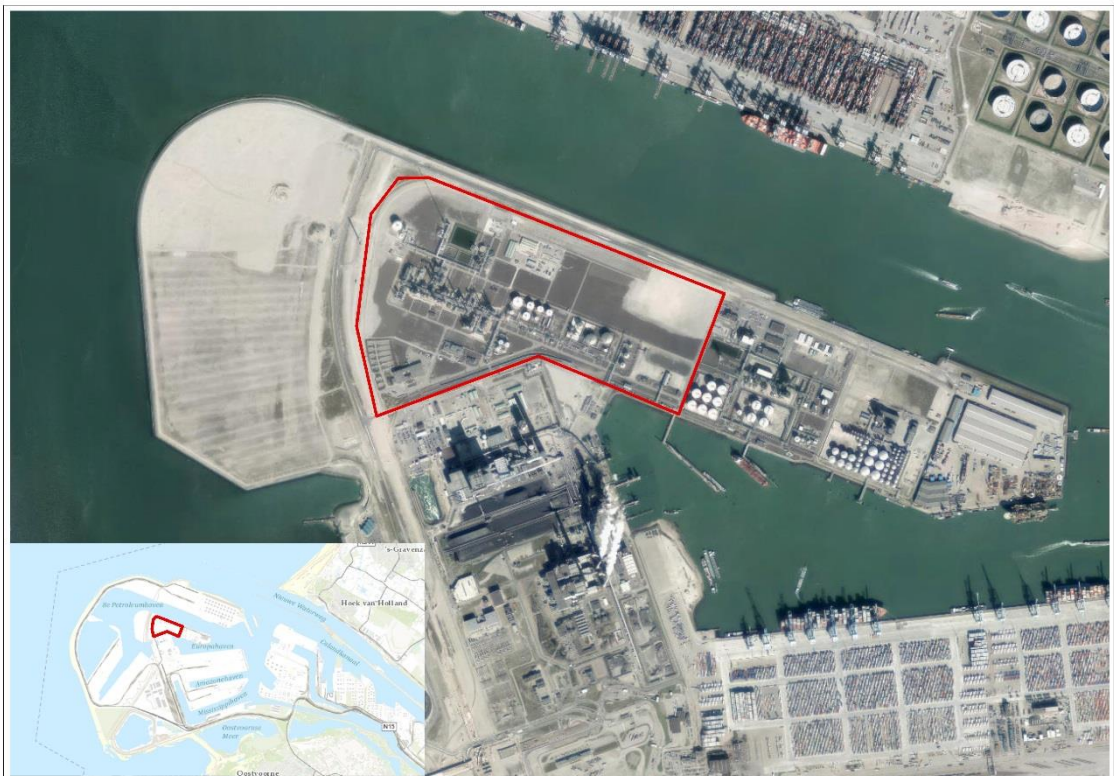
Figuur 1.1 Ligging LCNBV Maasvlakte 1 (rood omlijnd) Bron ondergrond: CycloMedia.
