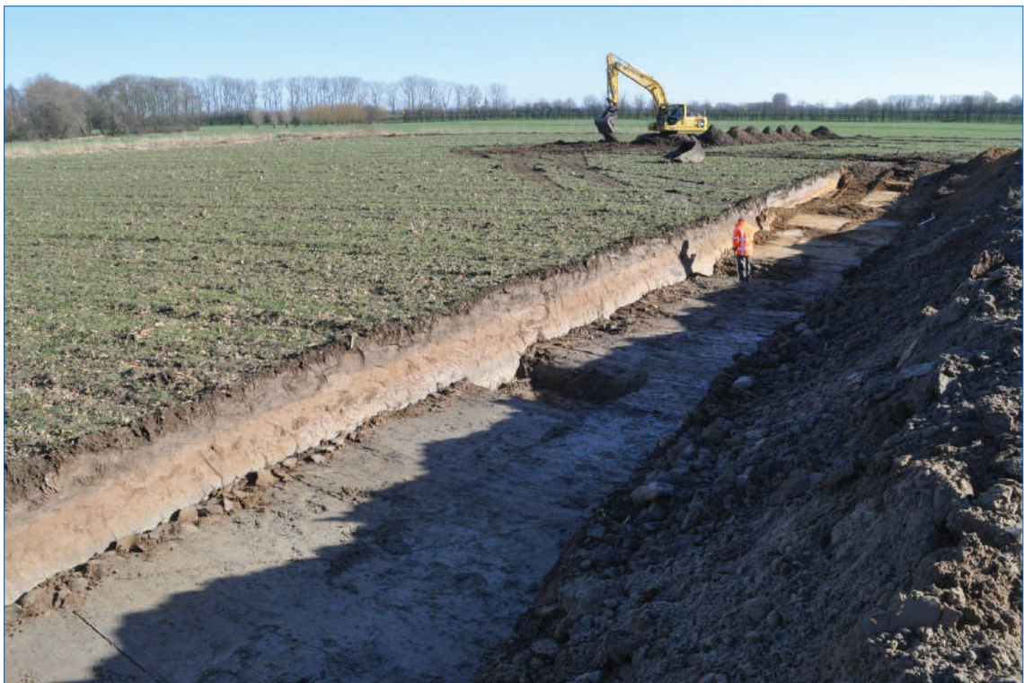
Figuur 6. Tweede vlak in WP 2 met dieper uitgegraven locaties van de profielkolommen (foto richting het zuidoosten)
