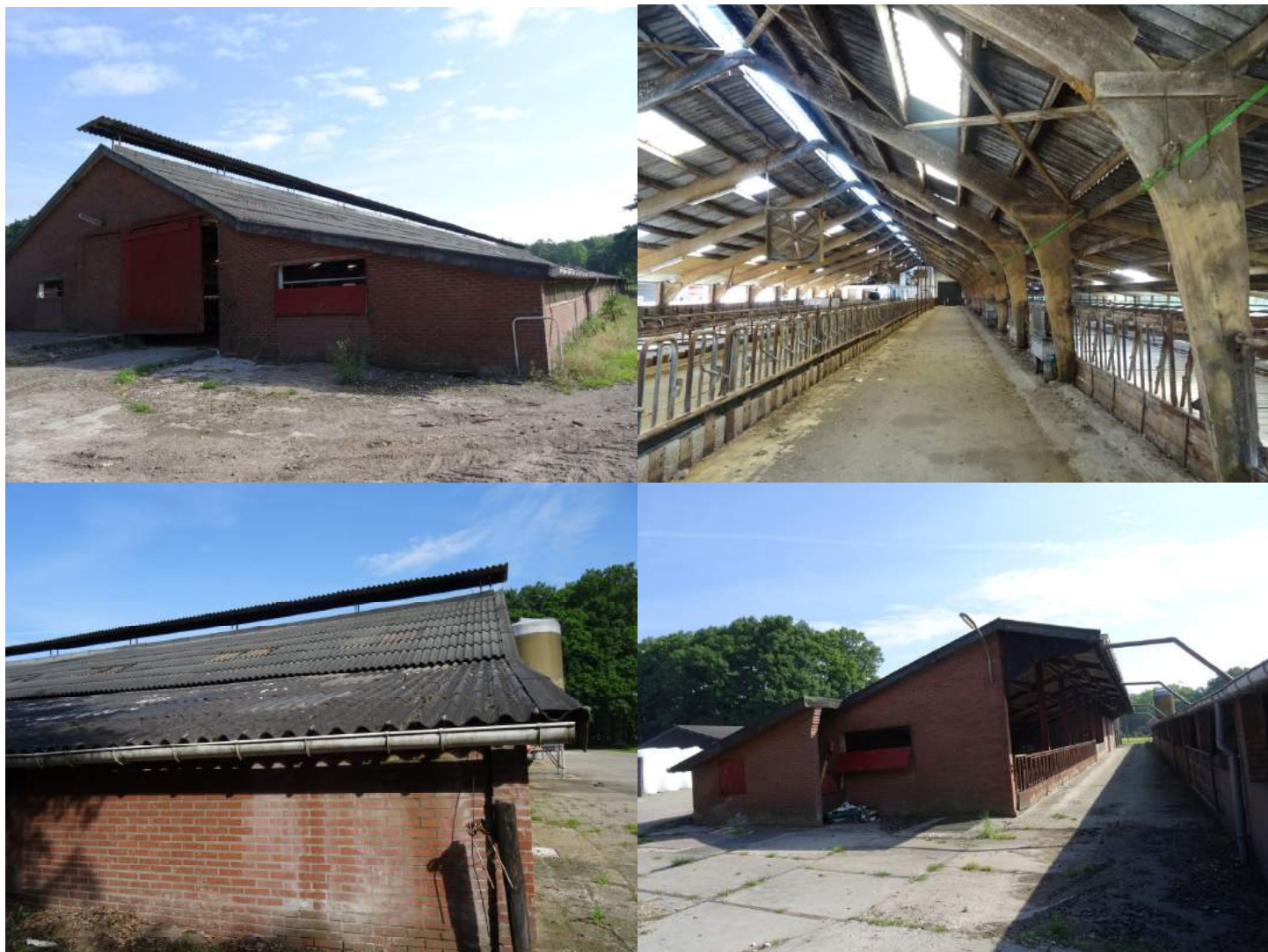
Figuur 9: Indruk van de te slopen gebouwen aan de Eikenstraat 3 te Ellecom.
