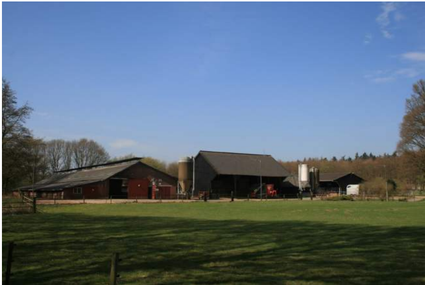
Zicht op de oostelijke zijde van het over-erf met links de koeienschuur en centraal de kapschuur.
