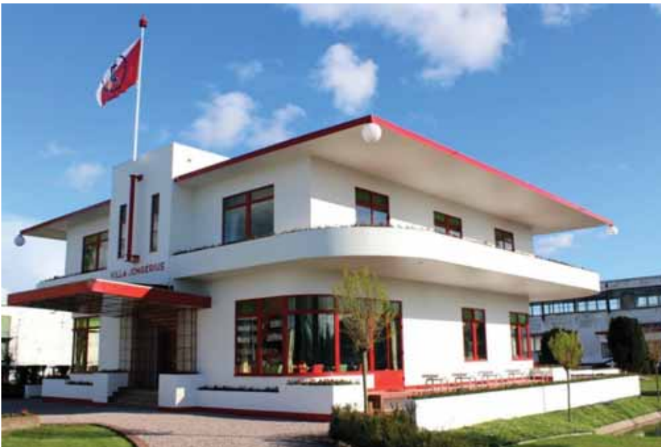
Afbeelding 15-3 Het (gerestaureerde) Jongeriuscomplex (FBW Architecten, 2015)
