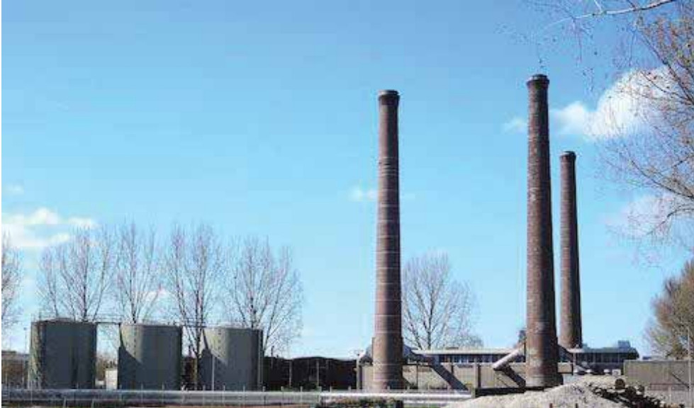
Afbeelding 15-4 De elektriciteitscentrale (Bron: Utrechtse Stichting voor het Industrieel Erfgoed ( www.usine-utrecht.nl ))
