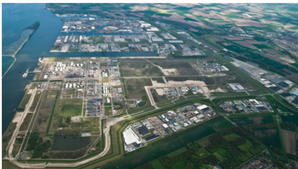
Figuur 3.1: Luchtfoto van het Zeehaven- en industrieterrein Moerdijk vanaf westzijde (bron: Havenbedrijf Moerdijk)
