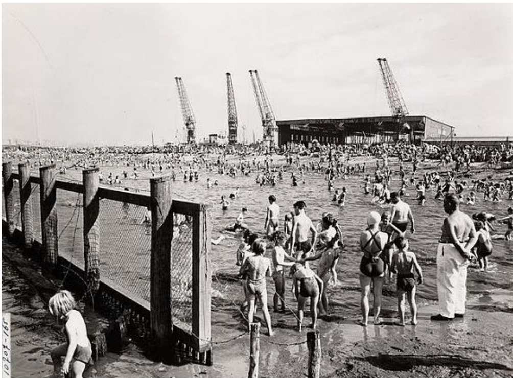
32. Was-, bad- en zweminrichting aan de Vlothaven op de achtergrond de loods van NV Houtveem, 1954, beeldbank SAA
