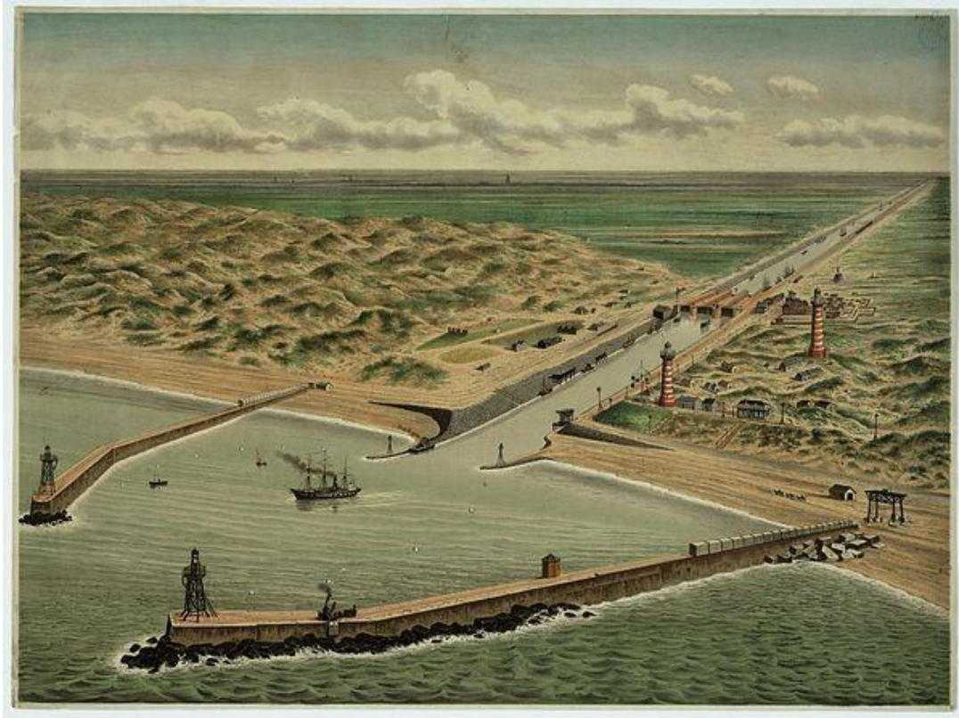
16. De Zeesluizen van het Noordzeekanaal, ongedateerd, beeldbank Stadsarchief Amsterdam
