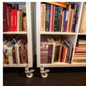
Kelders waterrobuust inrichten
