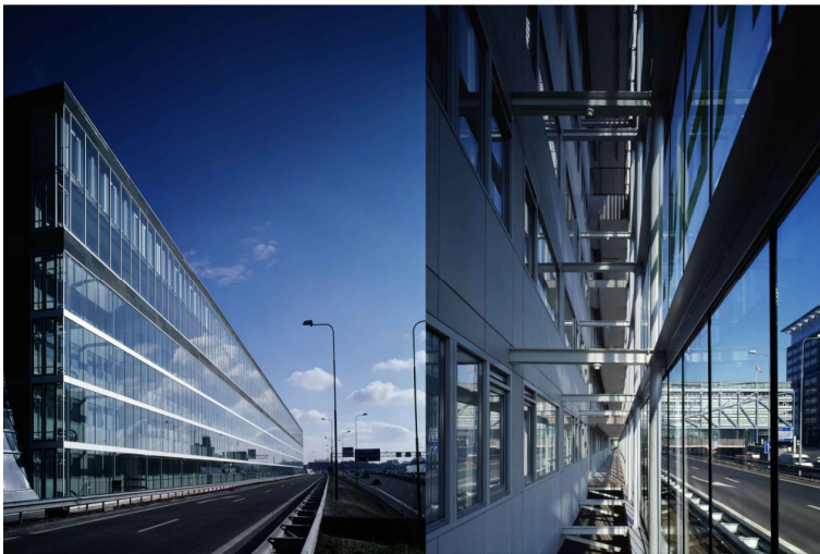
figuur 4 voorbeeld vliesgevel (Leeuw van Vlaanderen, Amsterdam), beeldmateriaal: Heren5 architecten
