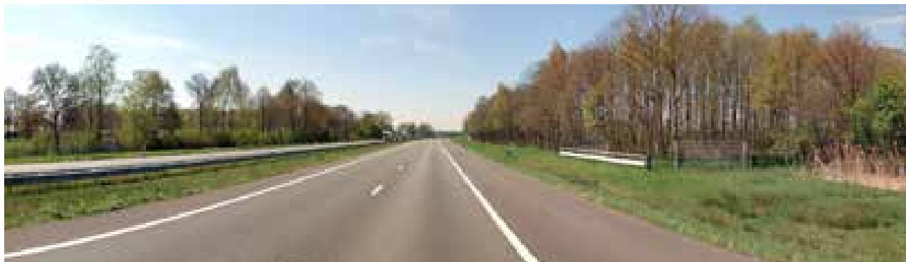
De kruising met de Regge is alleen zichtbaar aan de railing met geleiderail als bijzonder element in de berm
