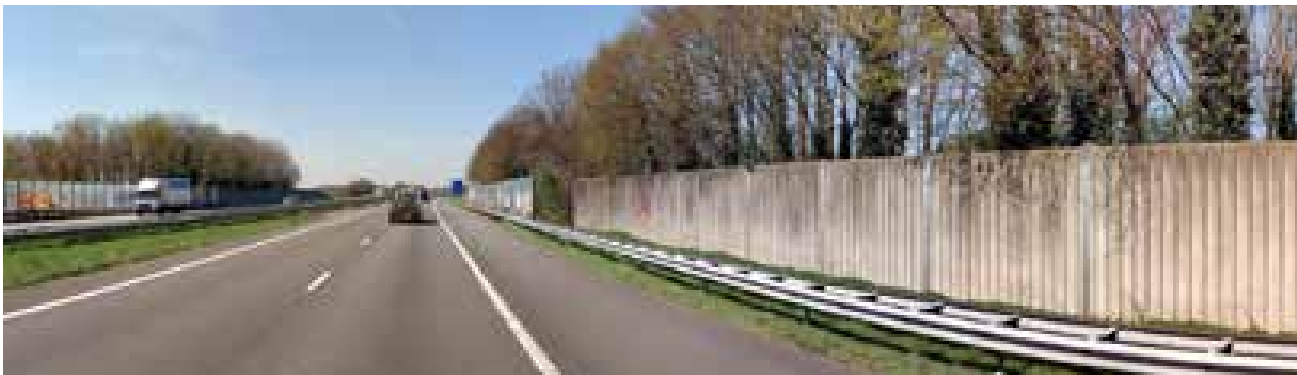
Geluidscherm bij Enter het verspringing in het scherm bij het viaduct; door het ontbreken van veel wegmeubilair is het beeld rustig [bron: Cyclomedia 2017]
