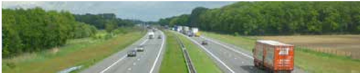
A1 ten oosten van Deventer, gezien vanaf Oxersteeg viaduct. Zicht naar oosten, huidig profiel met twee rijstroken per richting, royale bermen, en enkele geleiderails. Verlichtingsmasten en portalen zijn afwezig.
