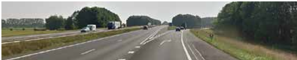
A1 ter hoogte van afslag 28 Rijssen / N347. Huidig profiel met twee rijstroken per richting en uitvoegstrook, royale bermen, enkele geleiderails in middenberm, geen rails in buitenberm
