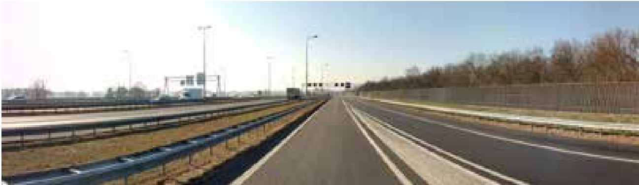
Geluidscherm bij Apeldoorn en het wegmeubilair van de A1 [bron: Cyclomedia 2017]
