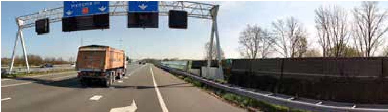
Geluidscherm bij Posterak met portaal en bijbehorende technische voorzieningen [bron: Cyclomedia 2017]
