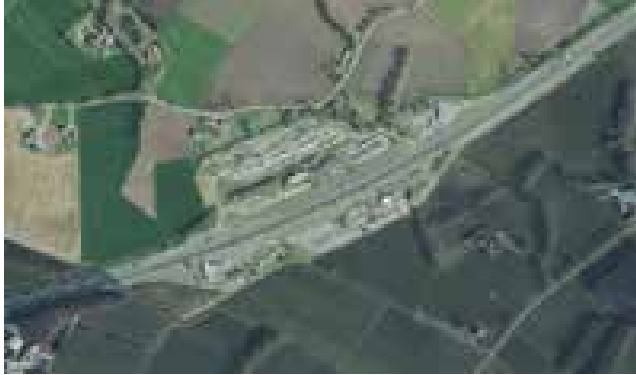
Verzorgingsplaats Struik en Bolder
