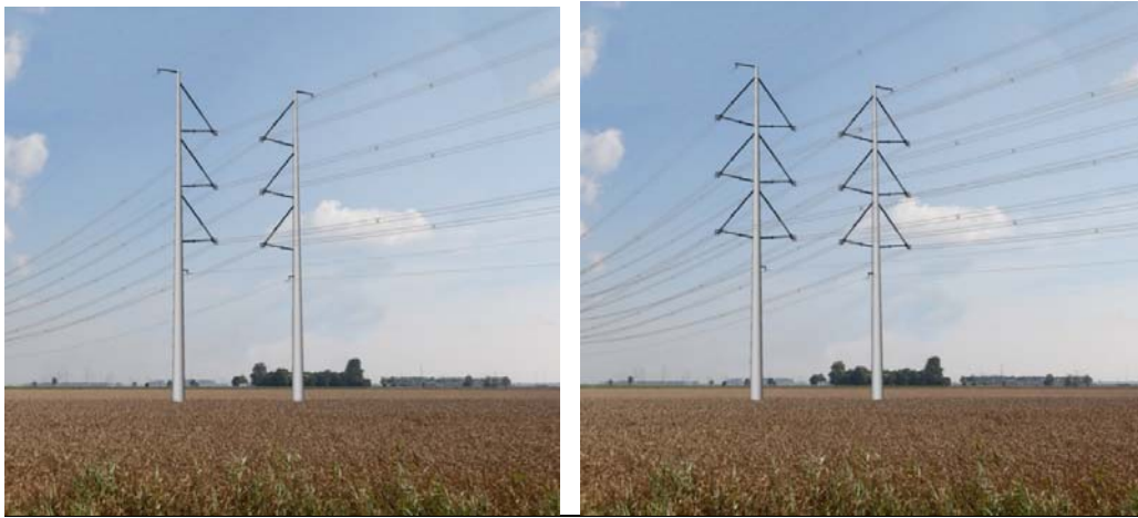
Figuur 2.1 Deelgebied 1 en 2, van links naar rechts: tijdelijke situatie (2 circuits 380 kV) en eindsituatie (4 circuits 380 kV)
