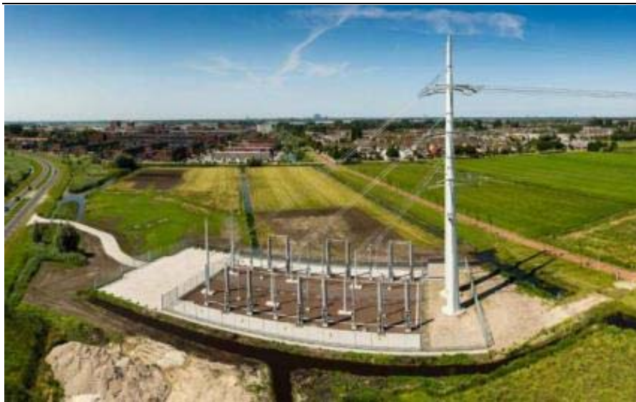
Figuur 2.10 Opstijgpunt Pijnacker langs de N470 (richting hoogspanningsstation Bleiswijk)
