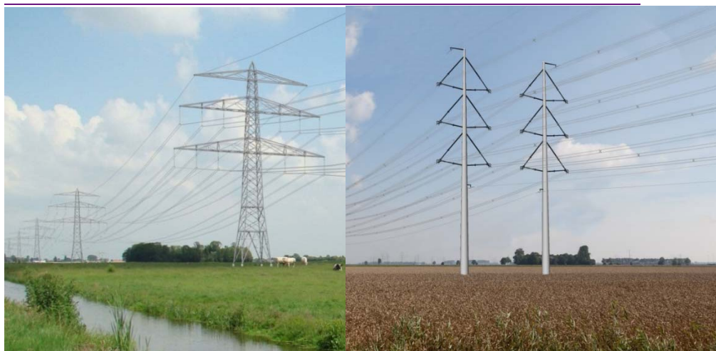
Figuur 2.3 Vakwerkmast (links) en wintrackmast (rechts)
