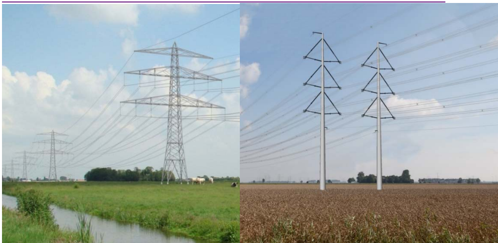
Figuur 2.3 Vakwerkmast (links) en wintrackmast (rechts)
