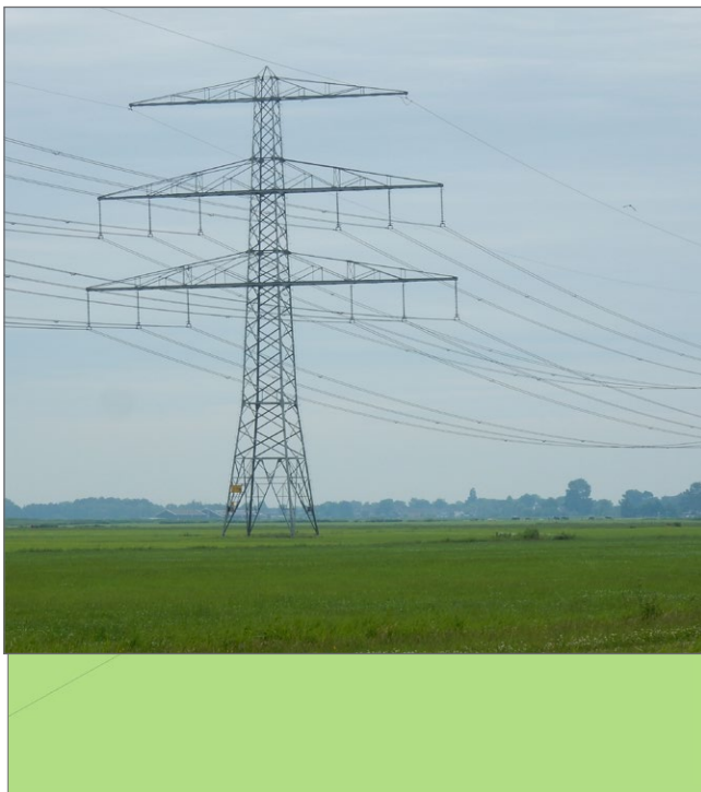
fig: 3 Bestaande vakwerkmast 4x220kV
