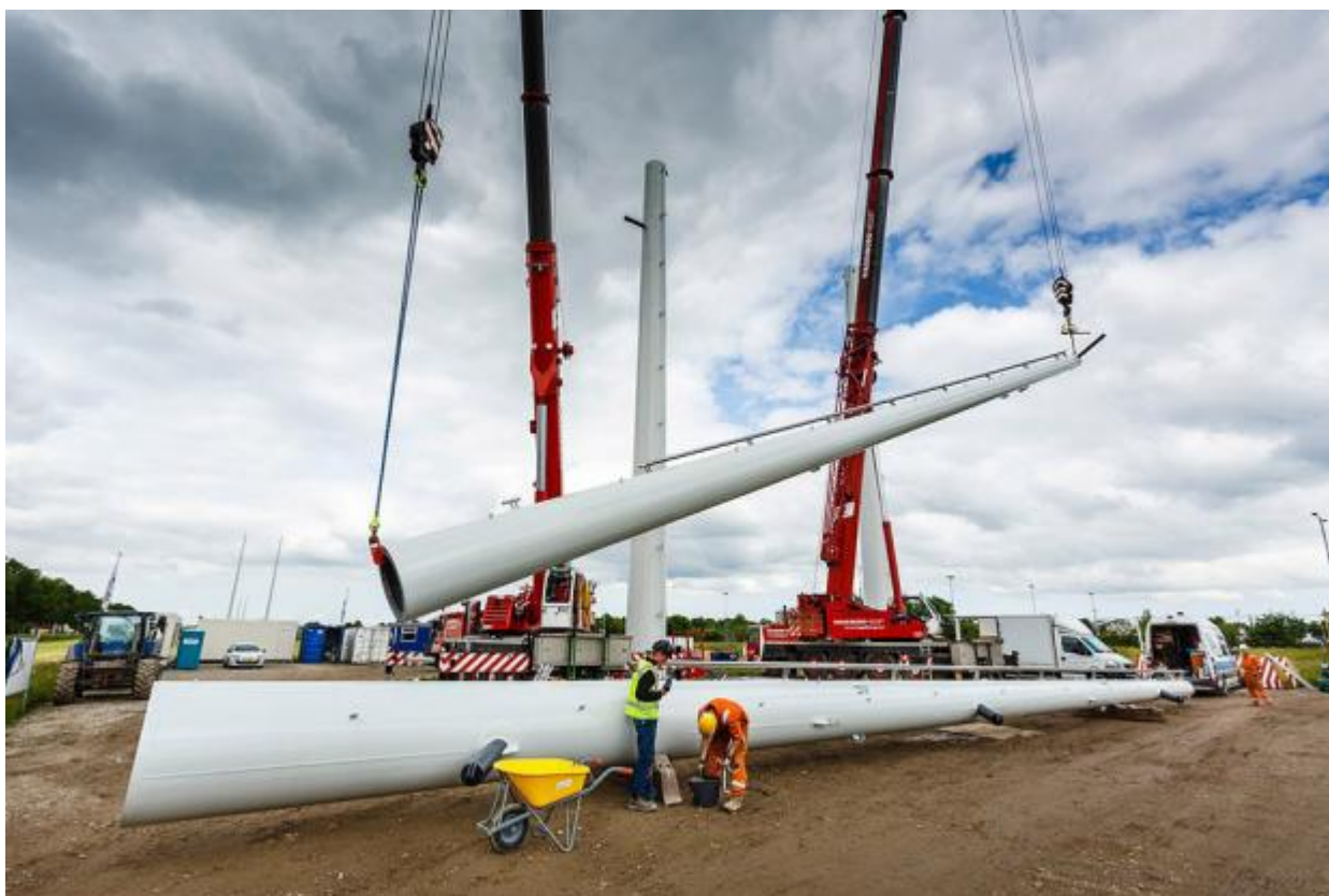
Figuur 9 plaatsing van een Wintrackmast
