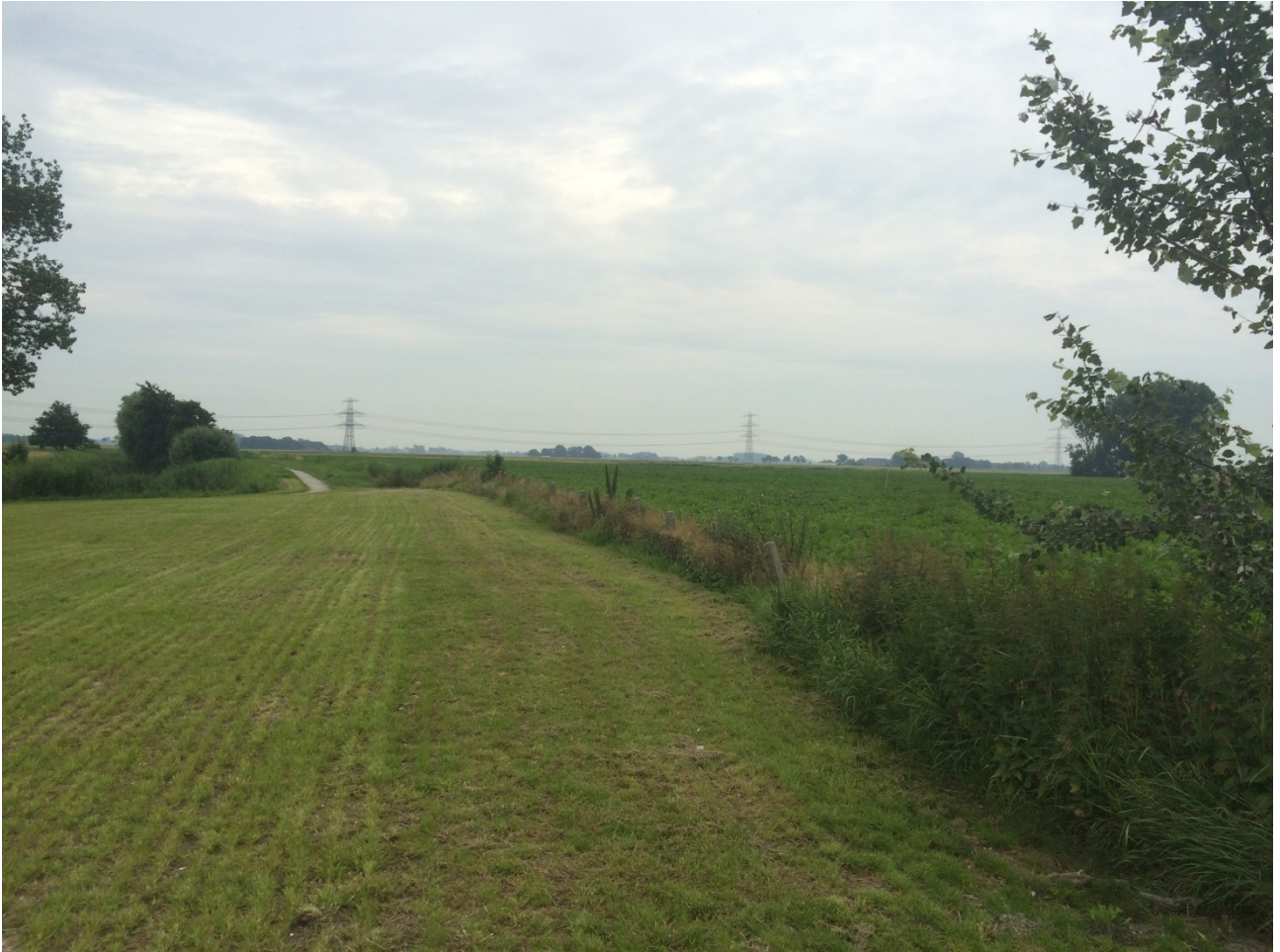
Foto vanaf de Bredeweg in het dorp Westeremden, kijkend op de bestaande 220 kV hoogspanningsverbinding.
