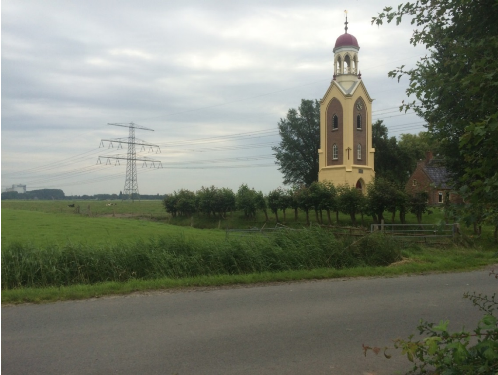
Foto van de monumentale kerktoeren met op de achtergrond de bestaande 220 kV hoogspanningsverbinding.
