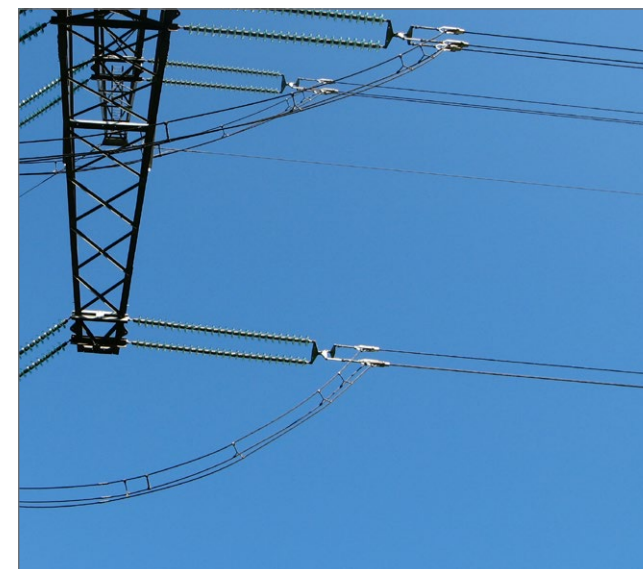
fig: 7 Geleiderbundel met 4 geleiders zoals zal worden toegepast in de nieuwe verbinding EOS-VVL
