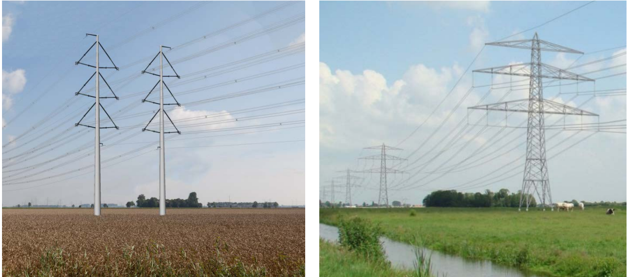
Figuur 6 links de nieuwe Wintrackmast, rechts een bestaande vakwerkmast
