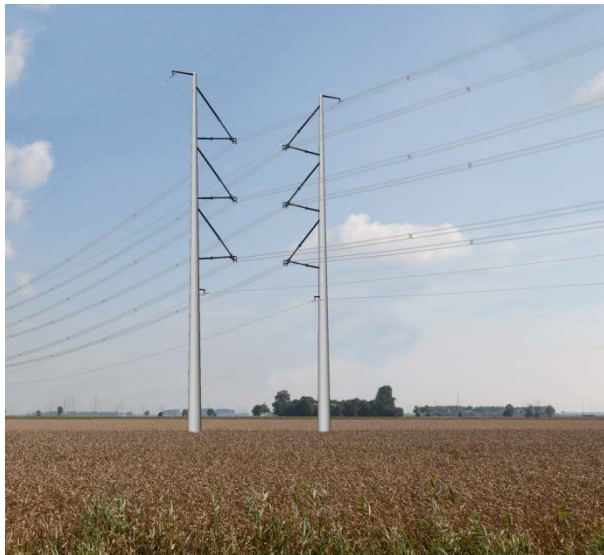
Figuur 7 links de situatie met twee circuits 380 kV, rechts de situatie met vier circuits 380 kV
