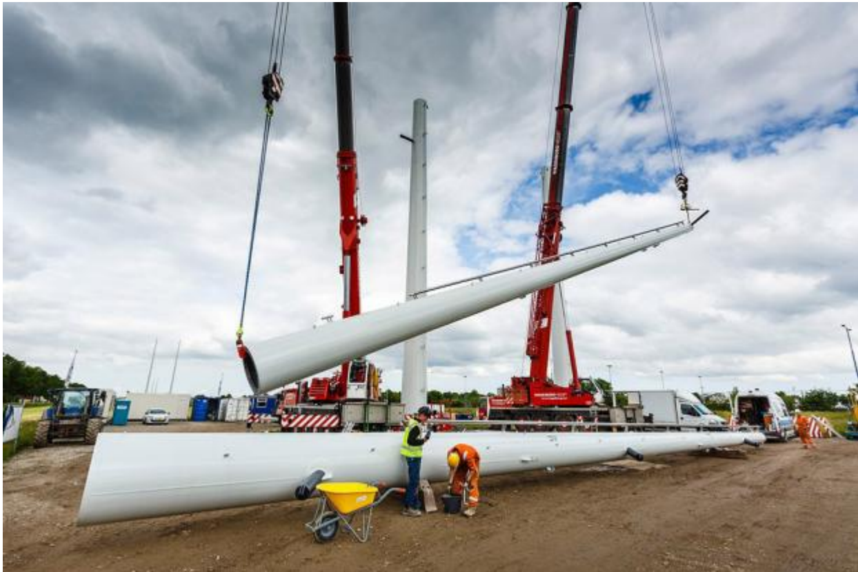
Figuur 9 plaatsing van een Wintrackmast
