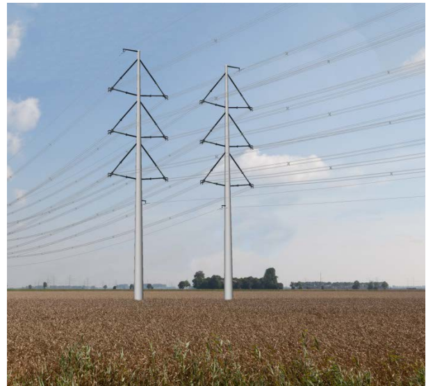
Figuur 7 links de situatie met twee circuits 380 kV, rechts de situatie met vier circuits 380 kV
