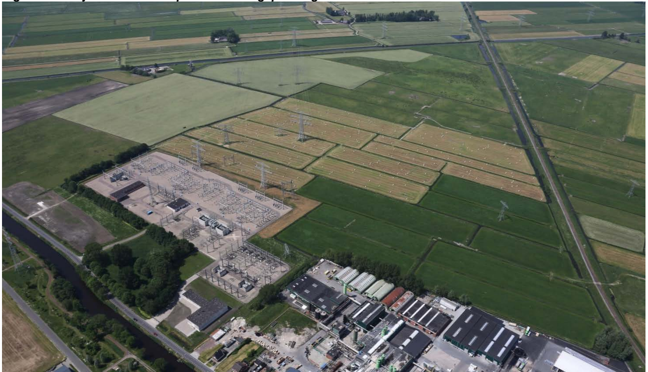
Figuur 3 bedrijventerrein Westpoort met hoogspanningsstation Vierverlaten
