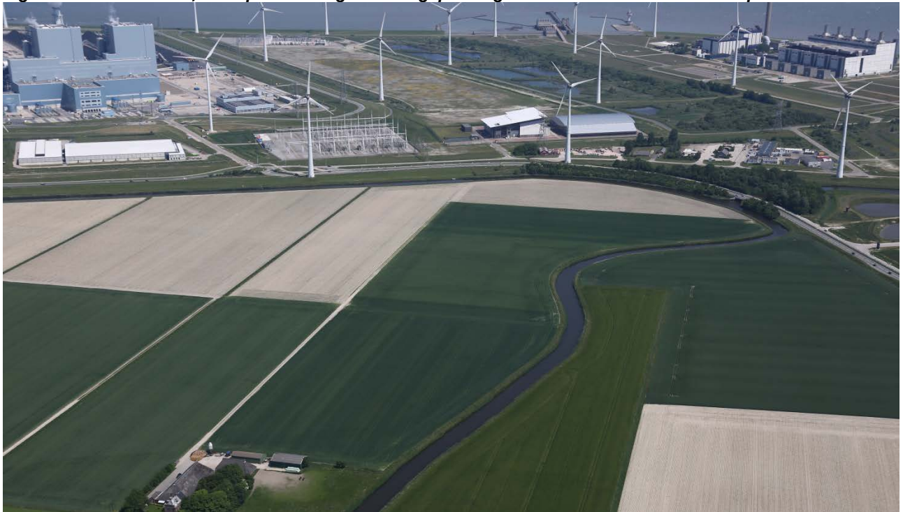
Figuur 2 de Eemshaven, met op de achtergrond hoogspanningsstation Eemshaven Oudeschip
