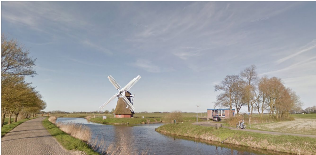
fig: 36 Krimstermolen aan het Boterdiep, rechts het gemaal aan het Harm Westerskanaal
