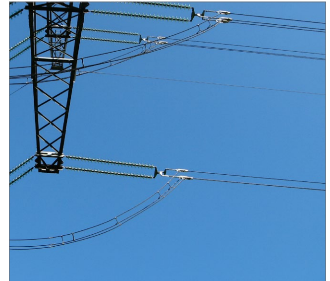
fig: 7 Geleiderbundel met 4 geleiders zoals zal worden toegepast in de nieuwe verbinding EOS-VVL
