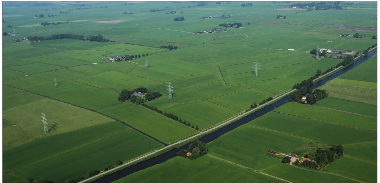
fig. 12 Luchtfoto Middag Humsterland nabij Brillerij. Boven met huidige 220kV lijn met vakwerkmasten. Onder met nieuwe 380kV verbinding met Wintrackmasten. De bestaande 110kV verbinding is afgebroken.
