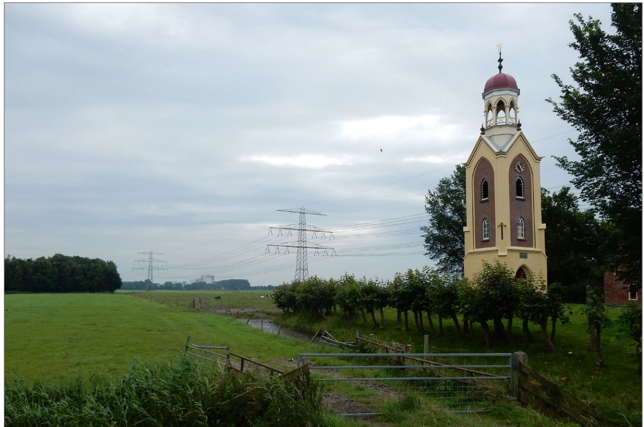
fig: 16 Toren van Westerdijkshorn met de te verwijderen 220kV lijn
