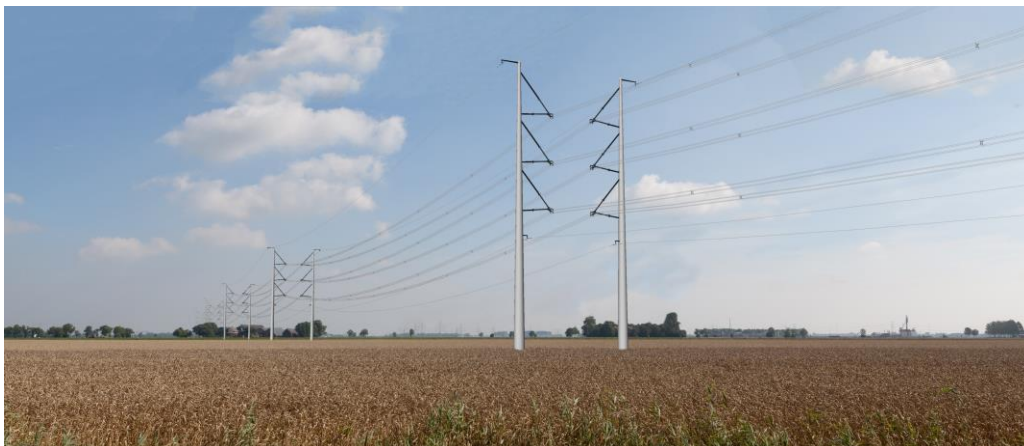
Foto 3: Wintrackmast met 2 circuits 380 kV
