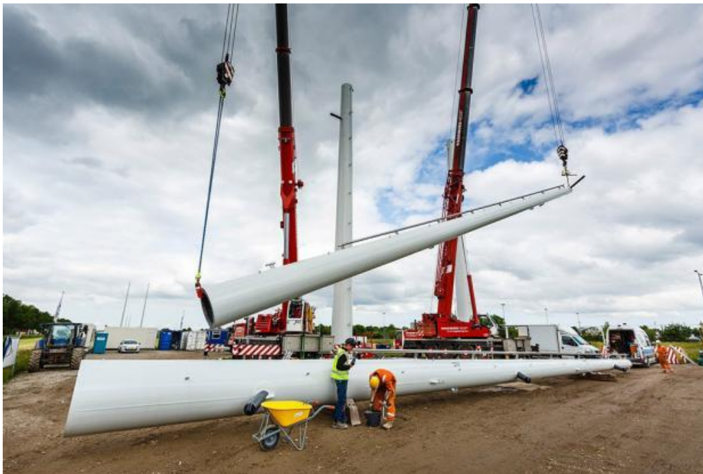
Foto 6: plaatsing van een Wintrackmast
