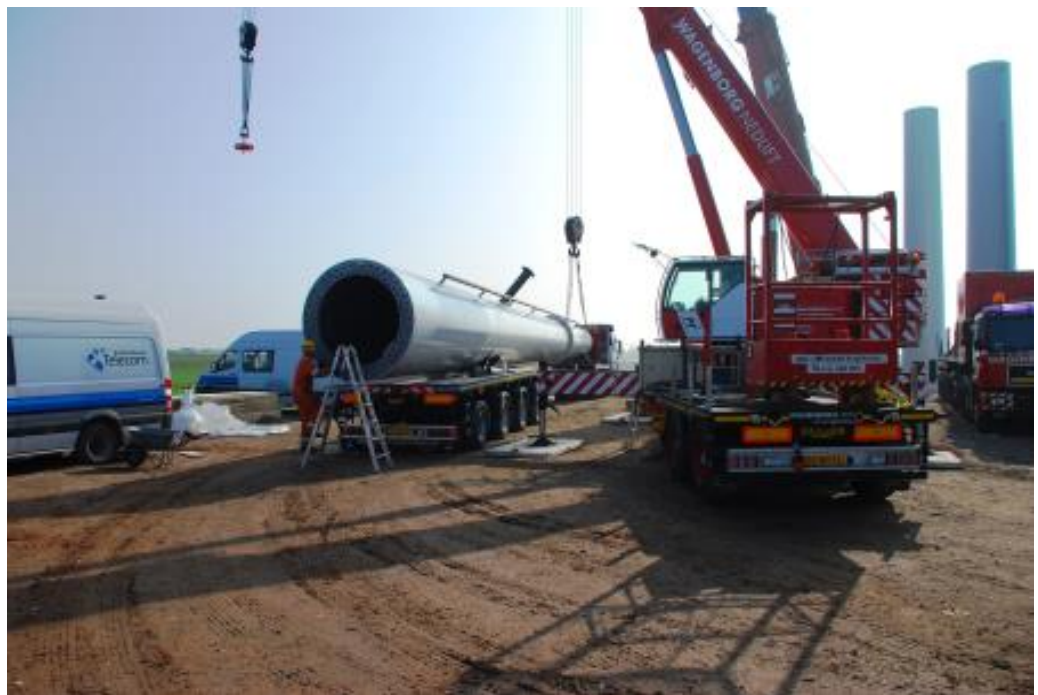
Foto 17: Assemblage mast
