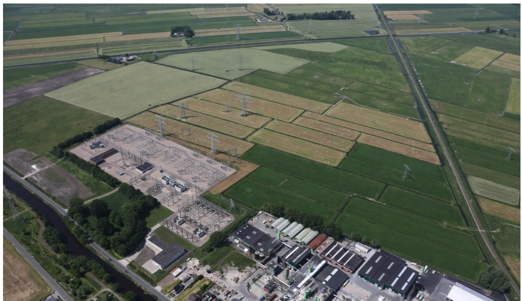
Foto 4: Bedrijventerrein Westpoort met transformatorstation Vierverlaten
