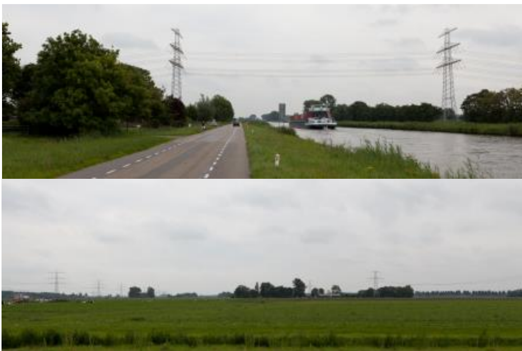
Foto 12: Aduarderdiep met bestaande 110 en 220 kV-verbindingen
