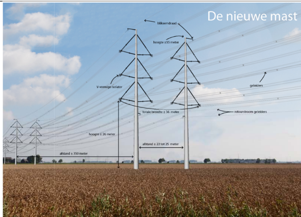
Figuur 1.2 Kenmerken van de nieuwe bipolemast.
