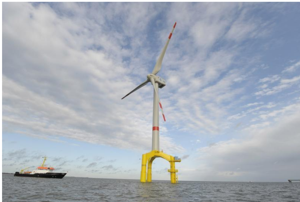
Figuur 2.5 Voorbeeld van een tripile fundatie 2 .
